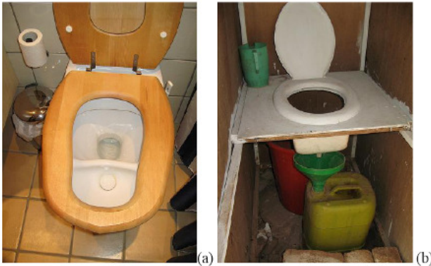
Figura 21: Vasos separadores de urina (Urine Divert Toilet - UDT). (a) Projeto EcoSan em Estocolmo, na Suécia. (b) Projeto EcoSan em Addis Ababa, na Etiópia.
