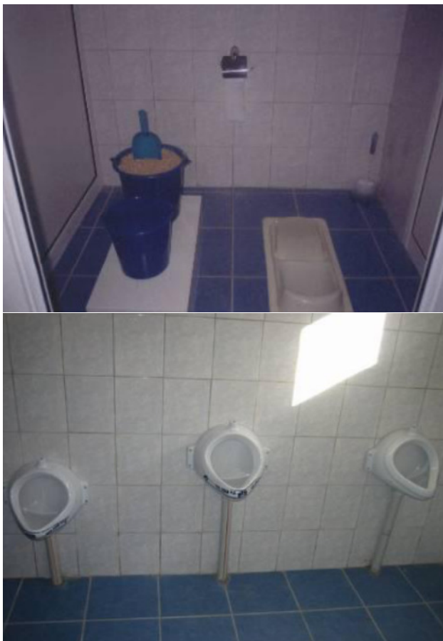
Figura 52: Detalhe do sanitário tipo cócoras e os mictórios instalados em alturas diferentes.
