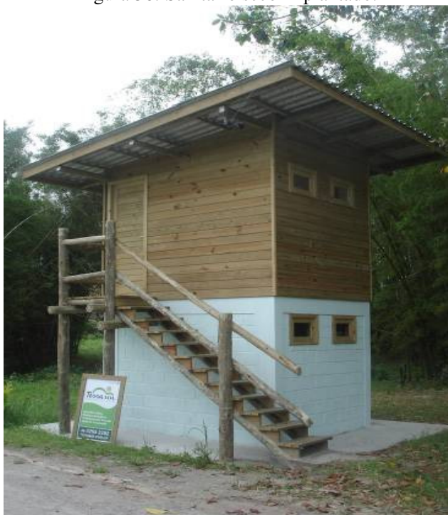
Figura 36: Sanitário seco implantado.
