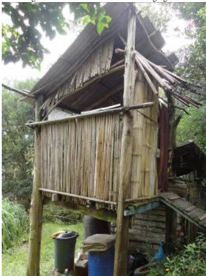
Figura 42: Vista externa do sanitário segregador.
