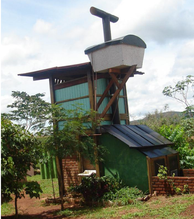
Figura 19: Húmus Sapiens, banheiro seco de fabricação local, de múltiplas câmaras.
