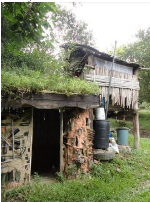
Figura 41: Vista externa dos sanitários.
