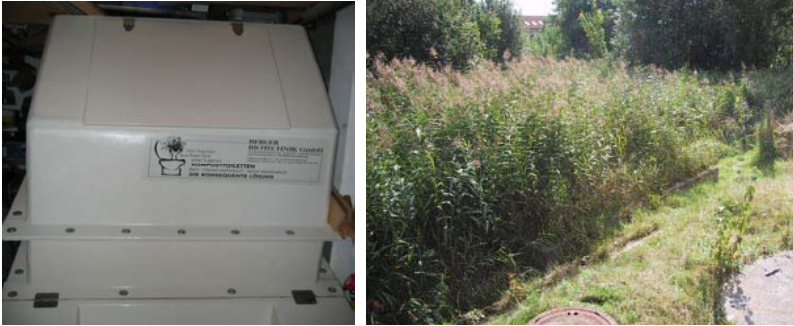
Figura 23: Sistema Berger de banheiro seco e wetland para tratamento das águas cinzas
