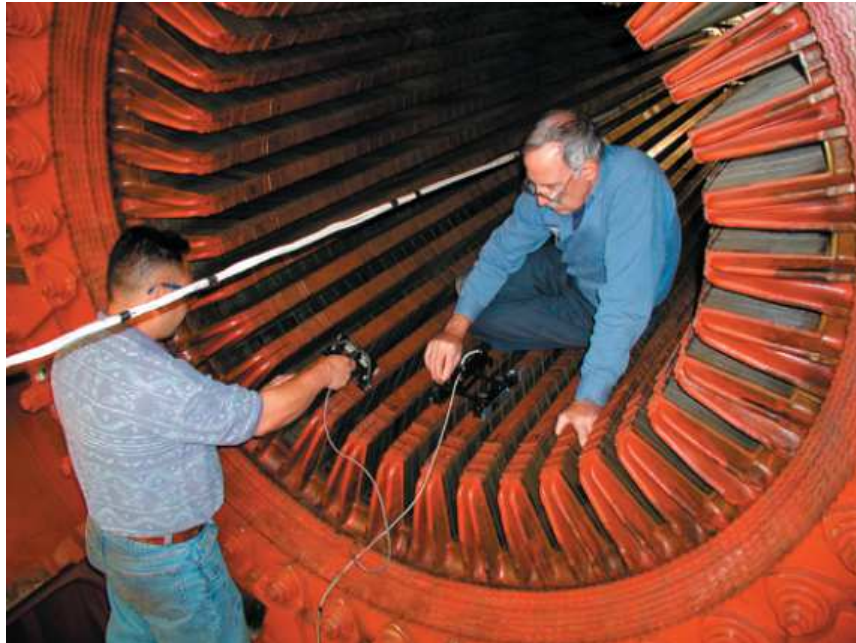
Figure 1.8 – Test El Cid en cours sur un stator d’alternateur [18]
