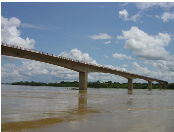
Figura 10: Ponte sobre o Rio Guaviare
