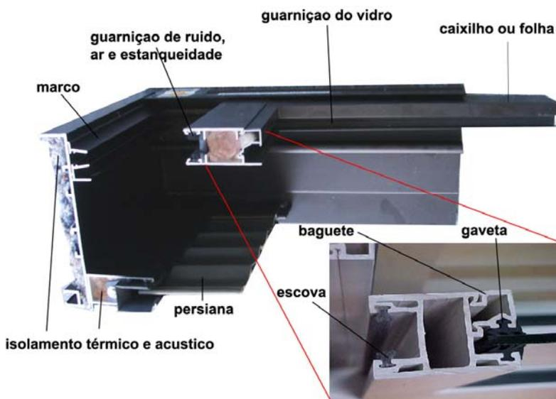
Figura 3.10 - Partes constituintes de uma esquadria. Fonte: Stylo Alumínio (2008)
