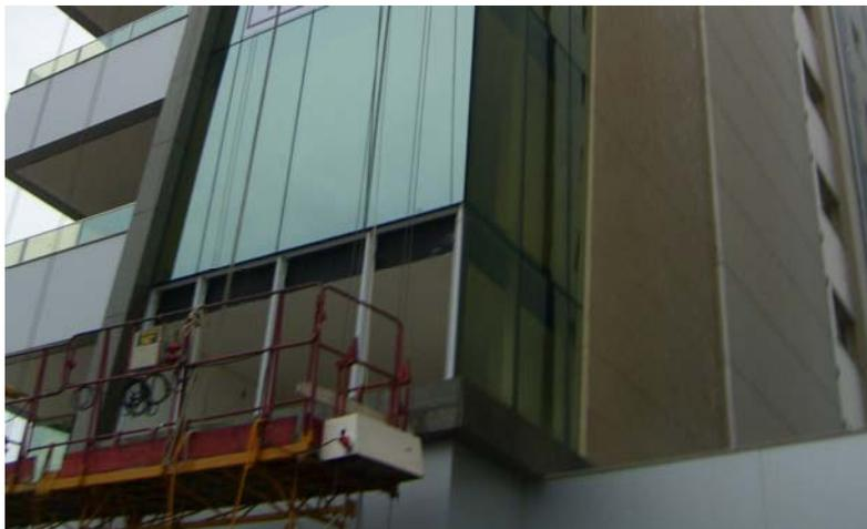
Figura 4.77 Colocação dos panos na estrutura da pele de vidro.
