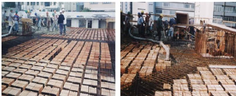
Figura 4.49 a- laje nervurada e b- viga chata
