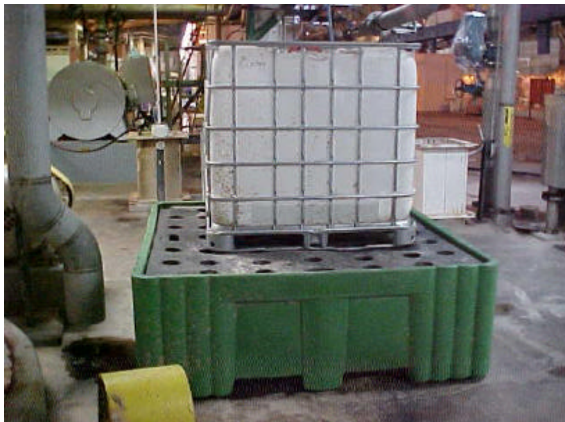
Figura 8 - Bacia de Contenção Móvel
