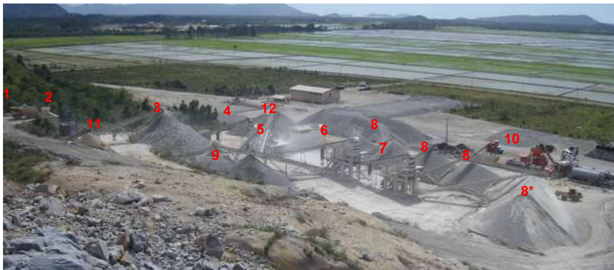
Figura 2.8 – Vista geral de uma planta de pedra: da britagem primária (esquerda - 2) à pilha de pó-de-pedra (direita - 8*).
