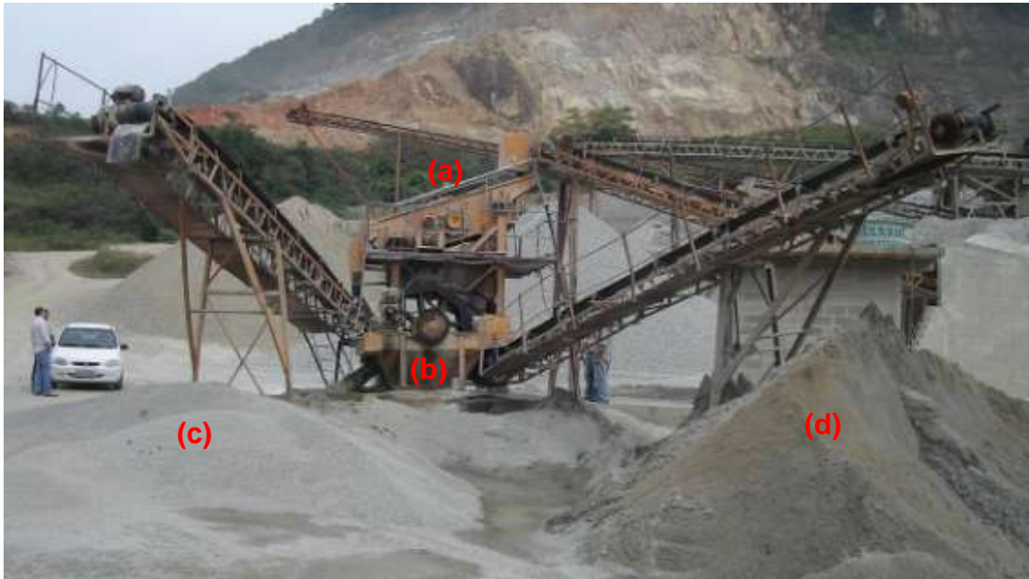
Figura 2.24 – Sistema beneficiamento do pó-de-pedra e produção de areia de britagem de uma pedra da região da grande Florianópolis: (a) peneiramento da granilha; (b) roda desaguadora para remoção de microfinos; (c) pilha de granilha; e (d) pilha de areia de britagem.
