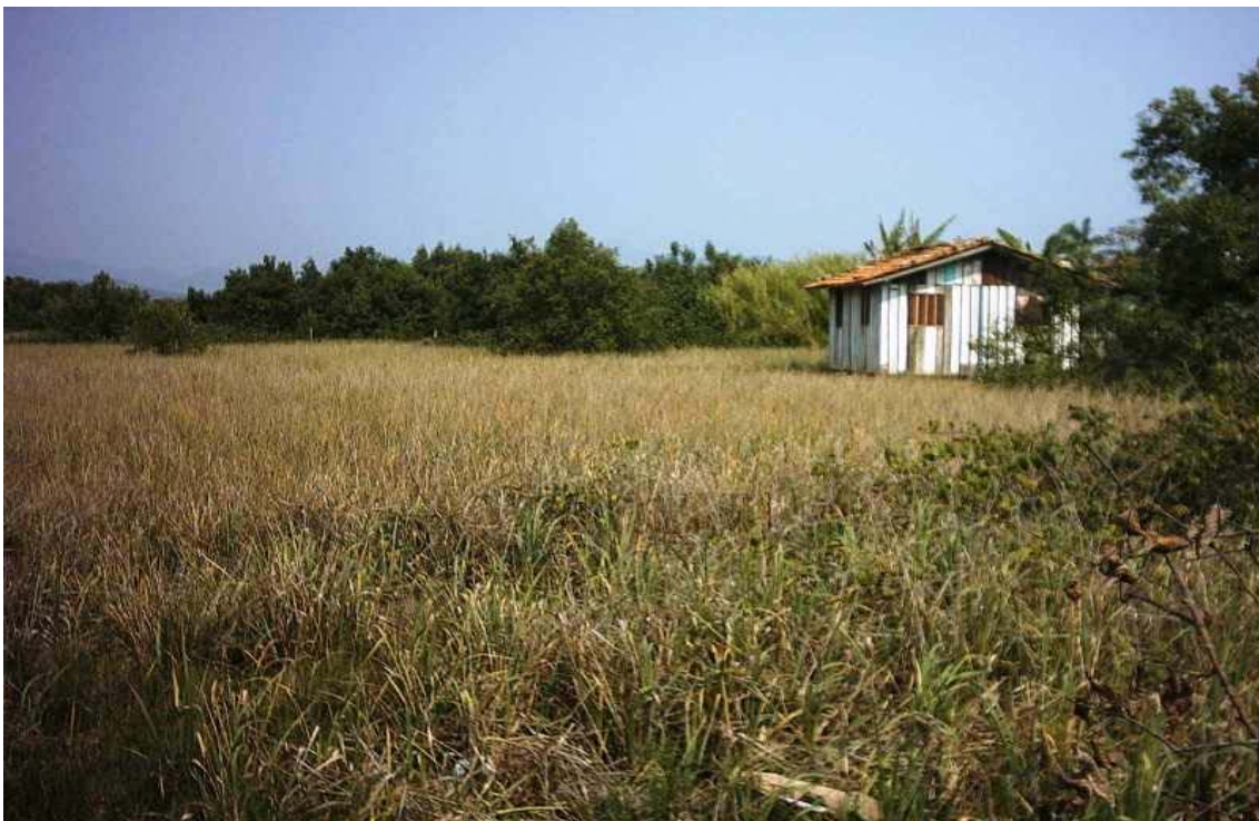
FOTO 05: Construção irregular, em área de preservação (manguezal), a menos de cem metros de distância da baía, no Loteamento Clarice.
