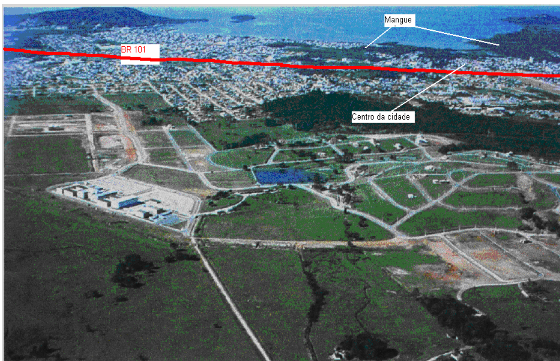
Figura 02: Vista aérea dos Loteamentos Pedra Branca e Pagani (às margens da BR 101, oeste). FONTE: Empreendimento Pedra Branca, 2000.
