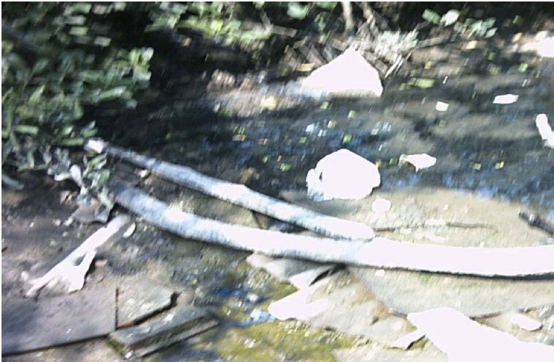
Foto 1: Esgoto a céu aberto em área de preservação permanente (Manguezal), no Loteamento Patural.
