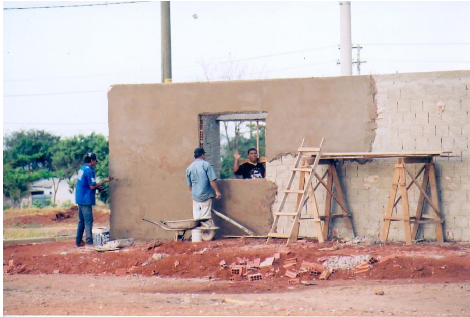
FIGURA 07: Casa de alvenaria. Bairro Dom Almir, 2000
