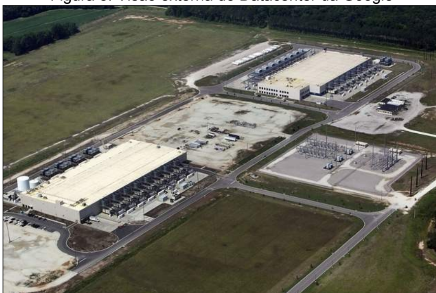
Figura 3: Visão externa do Datacenter da Google
