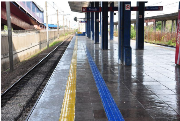
Figura 2: Piso guia. Fonte: Trensurb, 2012.
