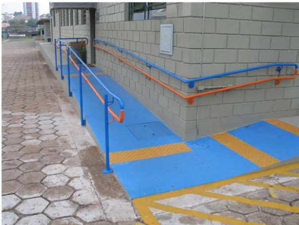
Figura 5: Rampas rebaixadas e corrimão.
