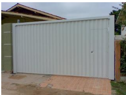
Figura 7 - Portão de correr em chapa búzio Fonte: Foto tirada pela autora
