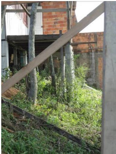
**Foto 3.4.** Detalhe da secção da escarpa arenosa com fundação rasa e pilares. Não houve intervenção geotécnica.
