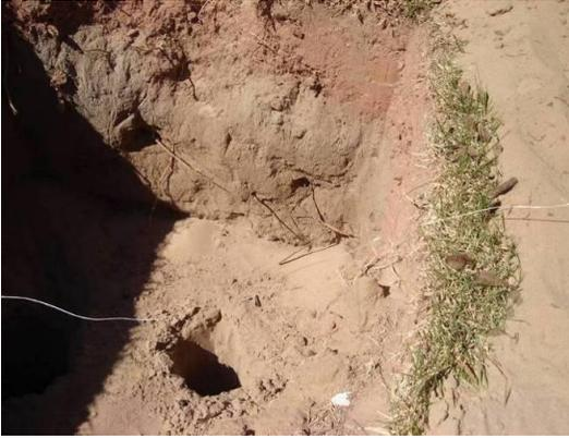
**Foto 3.1.** Solo arenoso com argila. Escavação para fundação do tipo bloco. Boa escavabilidade. Profundidade de 1m. Cabeçudas.
