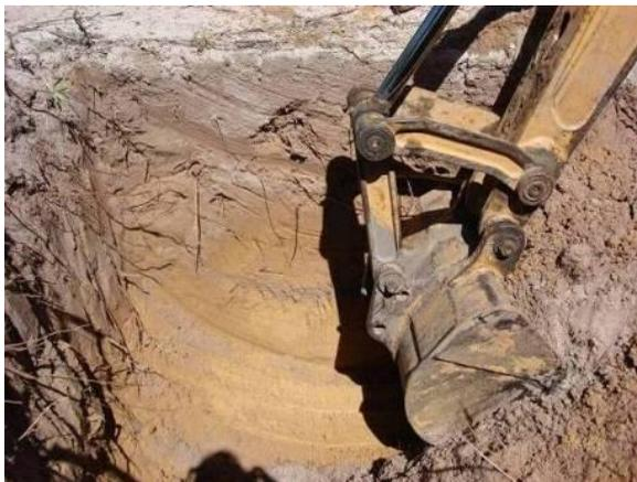
**Foto 1.2:** Escavação mecânica em solo coeso.
