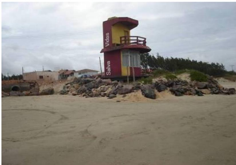
**Foto 3.21.** Erosão costeira causada pelo avanço do mar sobre a borda da duna frontal. Trabalhos de manutenção. Itapirubá.
