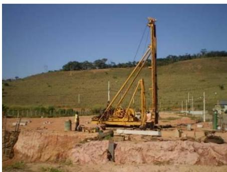
**Foto 1.4.** Implantação de fundação profunda do tipo estaca. Cortesia A. Lopes Estacas Ltda.
