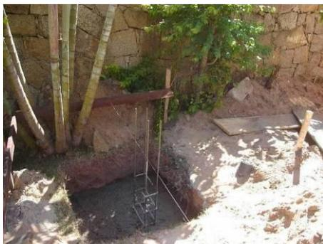
**Foto 1.3:** Vista de detalhe da fundação do tipo bloco com concreto e ferragem construída em solo de areia com finos.
