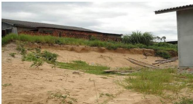
**Foto 3.7.** Corte na base da encosta dunária, provocando deslizamento. Roça Grande.
