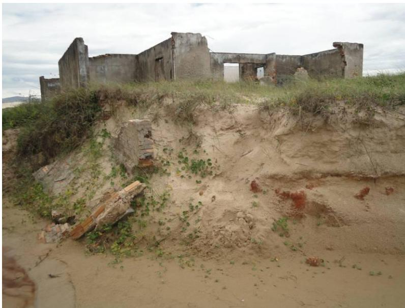
**Foto 4.12.** Erosão costeira e ação eólica sobre zona frontal da duna frontal. Danos na estrutura construída. Em primeiro plano, limite superior do estrêncio. Itapiruba.
