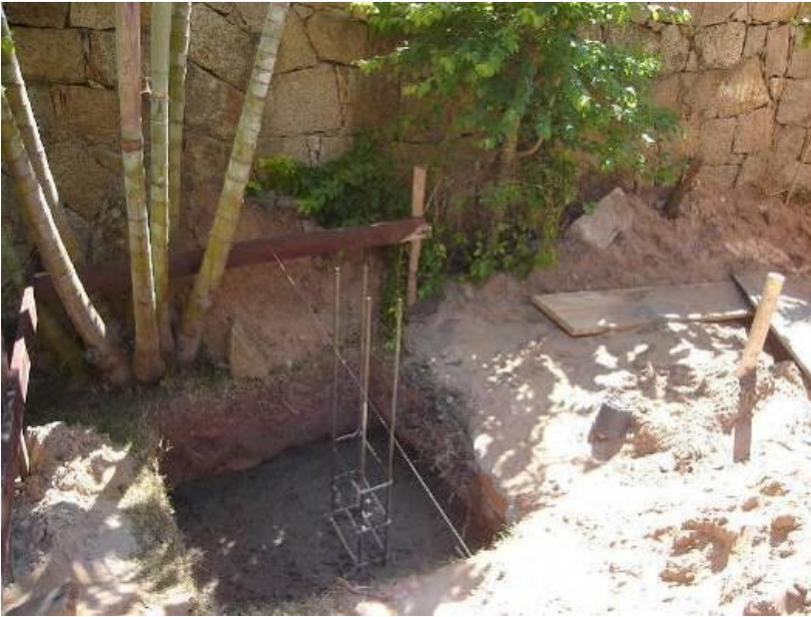
**Foto 4.1:** Detalhe da funda o rasa em alvenaria constru da em solo arenoso coeso.
