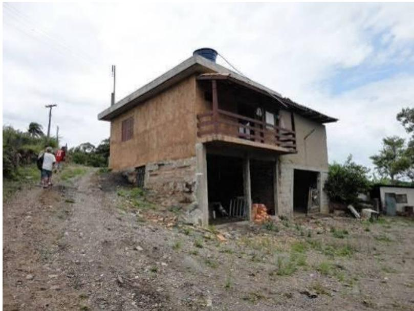
**Foto 4.3:** Moradia construída na escarpa arenosa com necessidade de corte e terraplenagem. Roça Grande.
