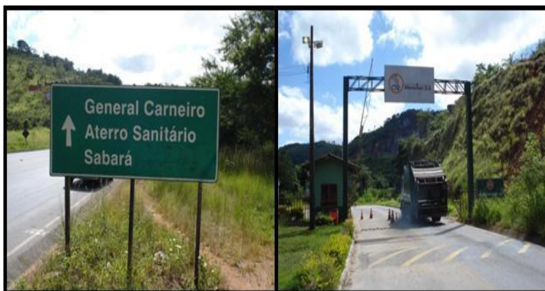
Figura 23: Entrada do aterro sanitário Macaúbas.
