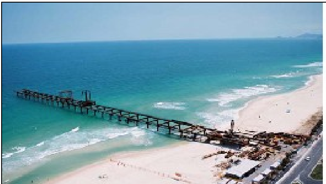
Figura 3.15: - Exemplo de Ponte Metálica Provisória em Construção (Interdição de faixa da praia e mar) – Praia Grande/SP.
