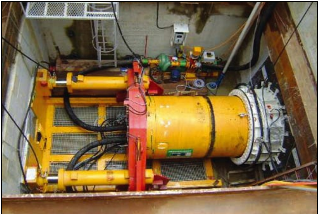
Figura 3.19 - Shield sendo introduzido no furo de saída da Câmara Compensadora de Pressão.
