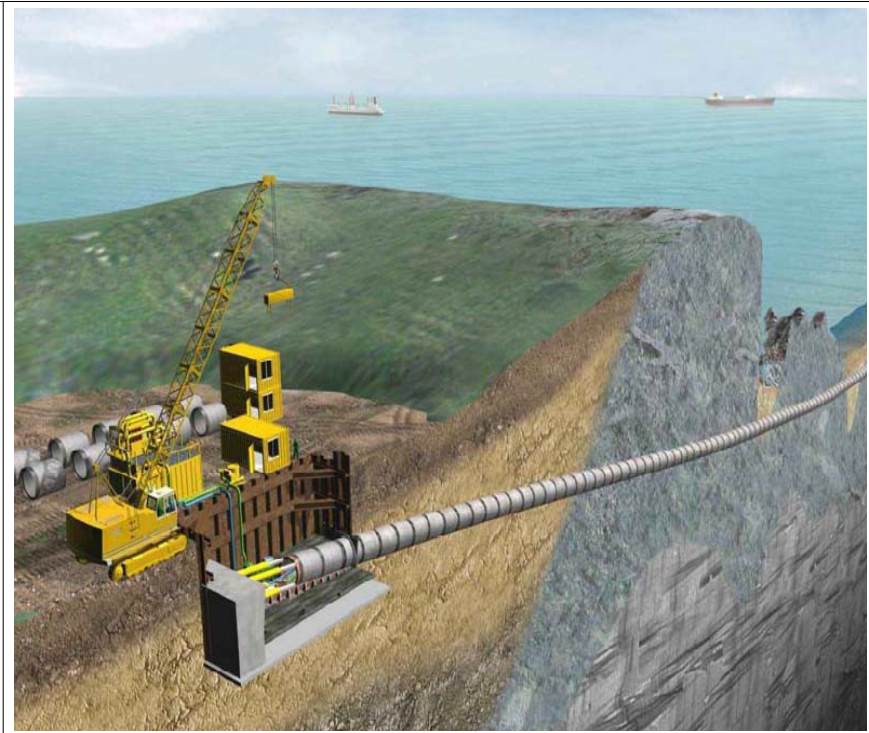
Figura 3.21: Perfil da Tubulação
