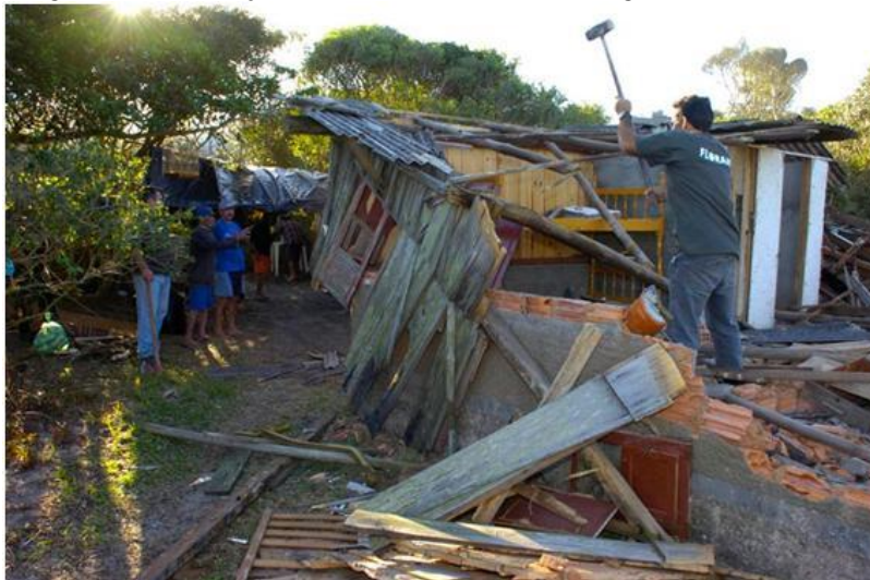
Fotografia 21: Demolição de ranchos na Praia de Naufragados.
