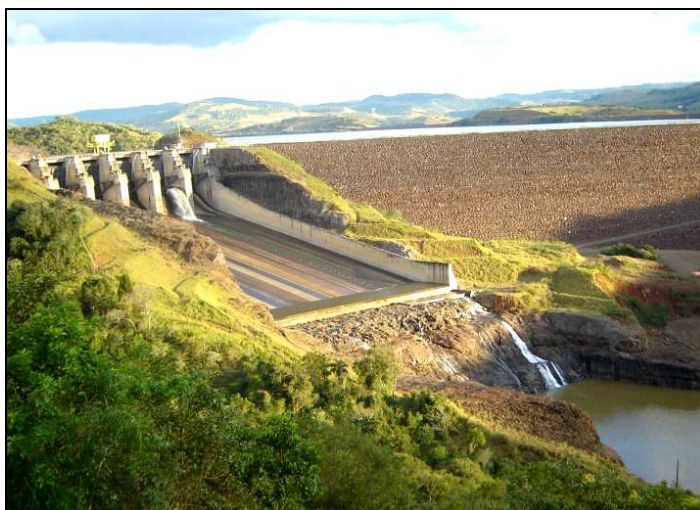
Fig. 1. Vista da barragem, vertedouros e parte do reservatório da UHE Itá (Itá, SC).
