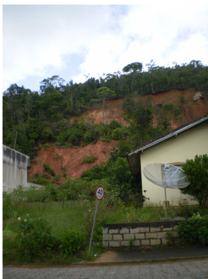
Figura 6.36 – Deslizamento de terra e rocha em um corte mal dimensionado e não estabilizado na Rua João Henrique Pauli, em 22 de novembro de 2008. Esta área é uma antiga saibreira, que depois de desativada foi loteada. Foto: Prefeitura Municipal de Antônio Carlos, 27 nov. 2008.
