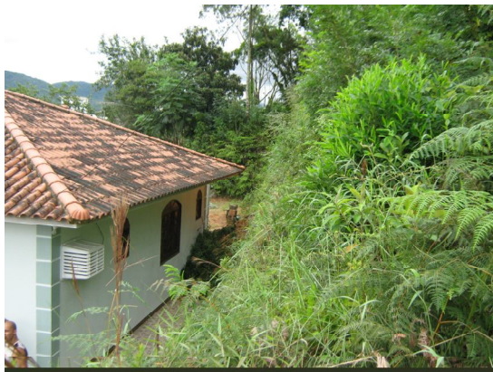
Figura 6.43 – Vista da residência em relação ao corte na encosta. Observar a proximidade da casa em relação ao corte e a altura deste em relação à casa. Foto: Prefeitura Municipal de Antônio Carlos, 26 mar. 2010.
