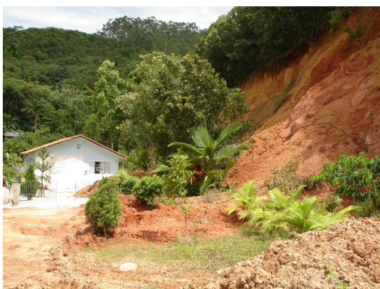
Figura 6.28 – Deslizamento próximo a uma residência na área urbana, que ocasionou a queda de uma árvore a menos de 2 m da residência. Foto: Prefeitura Municipal de Antônio Carlos, 01 fev. 2008.
