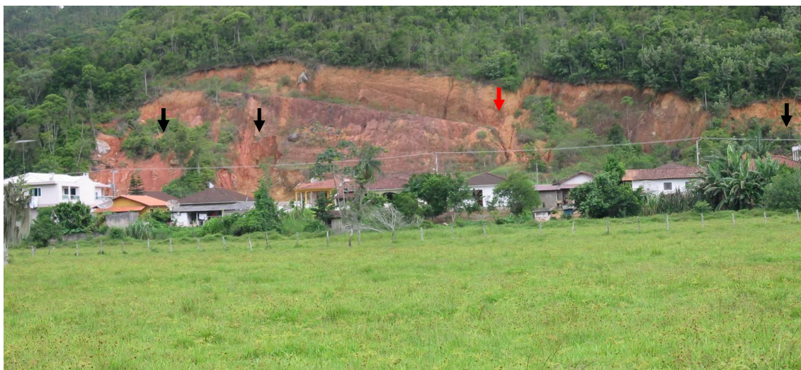
Figura 6.47 – Vista do corte na encosta da Rua Libório Francisco Goedert. A seta em vermelho indica um deslizamento ocorrido no evento de janeiro de 2008. As setas em preto, os deslizamentos ocorridos em novembro de 2008. Observar próximo às duas setas da parte esquerda da figura, os blocos de rocha imersos no manto de alteração. Foto: Joel Pellerin, jan. 2010.
