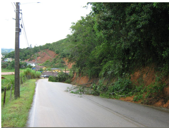
Figura 6.42 – Deslizamento na Rua Antônio José Zimmermann, que deixou o trânsito em meia pista. A encosta ao fundo na figura possui problemas de instabilidade provocados por deslizamentos no evento que ocorreu em novembro de 2008, que estão sendo retrabalhados a cada novo episódio pluviométrico e por conter surgência de água na sua base. Foto: Prefeitura Municipal de Antônio Carlos, 26 mar. 2010.
