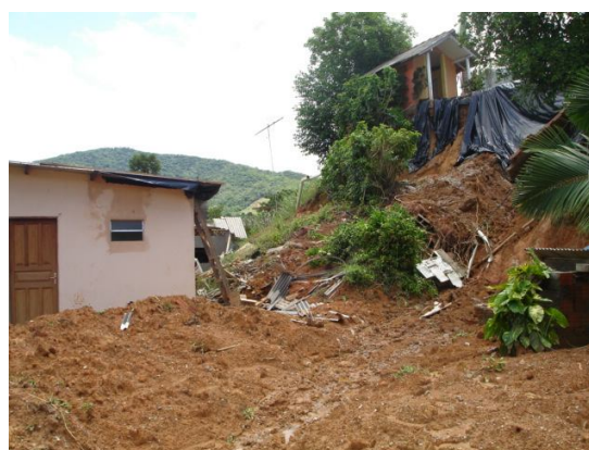
Figura 6.29 – Deslizamento (na área urbana) em um corte com degraus mal dimensionados, que danificou a estrutura da casa de cima e ocasionou o entulhamento da residência abaixo. Foto: Prefeitura Municipal de Antônio Carlos, 01 fev. 2008.
