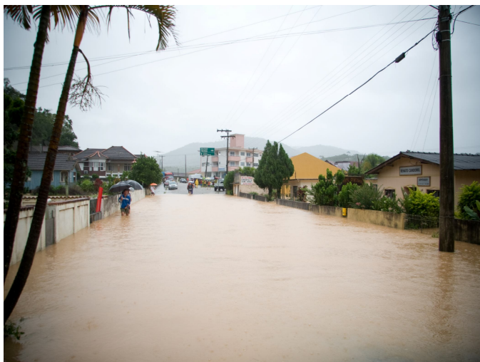
Figura 6.27 - Rua João Henrique Pauli e residências inundadas por terem sido construídas sobre um curso de água canalizado. Foto: PM de Antônio Carlos, 31 jan. 2008.
