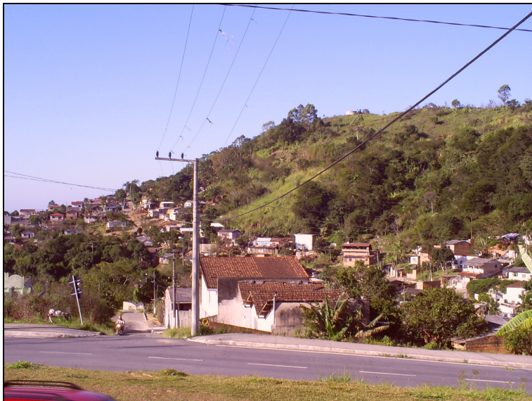
Figura 31 - Vista do local onde permaneceram algumas famílias
