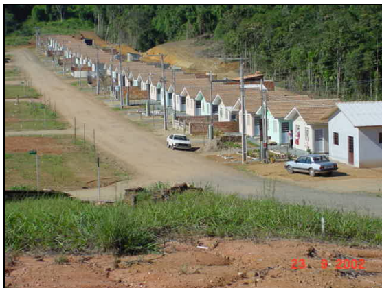
Figura 26 - Obras de acesso a Jaraguá 84
