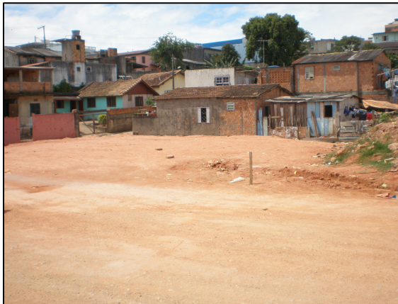
Figura 7 - Abertura de espaços para construção de casas
