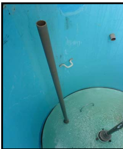
Figura 22 - Foto do tubo igualador de pressão (suspiro)
