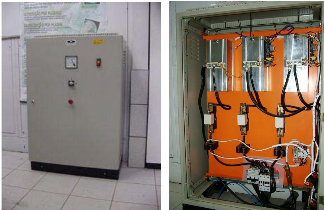
Figura 3.12 - Painel de controle do aquecimento resistivo.
