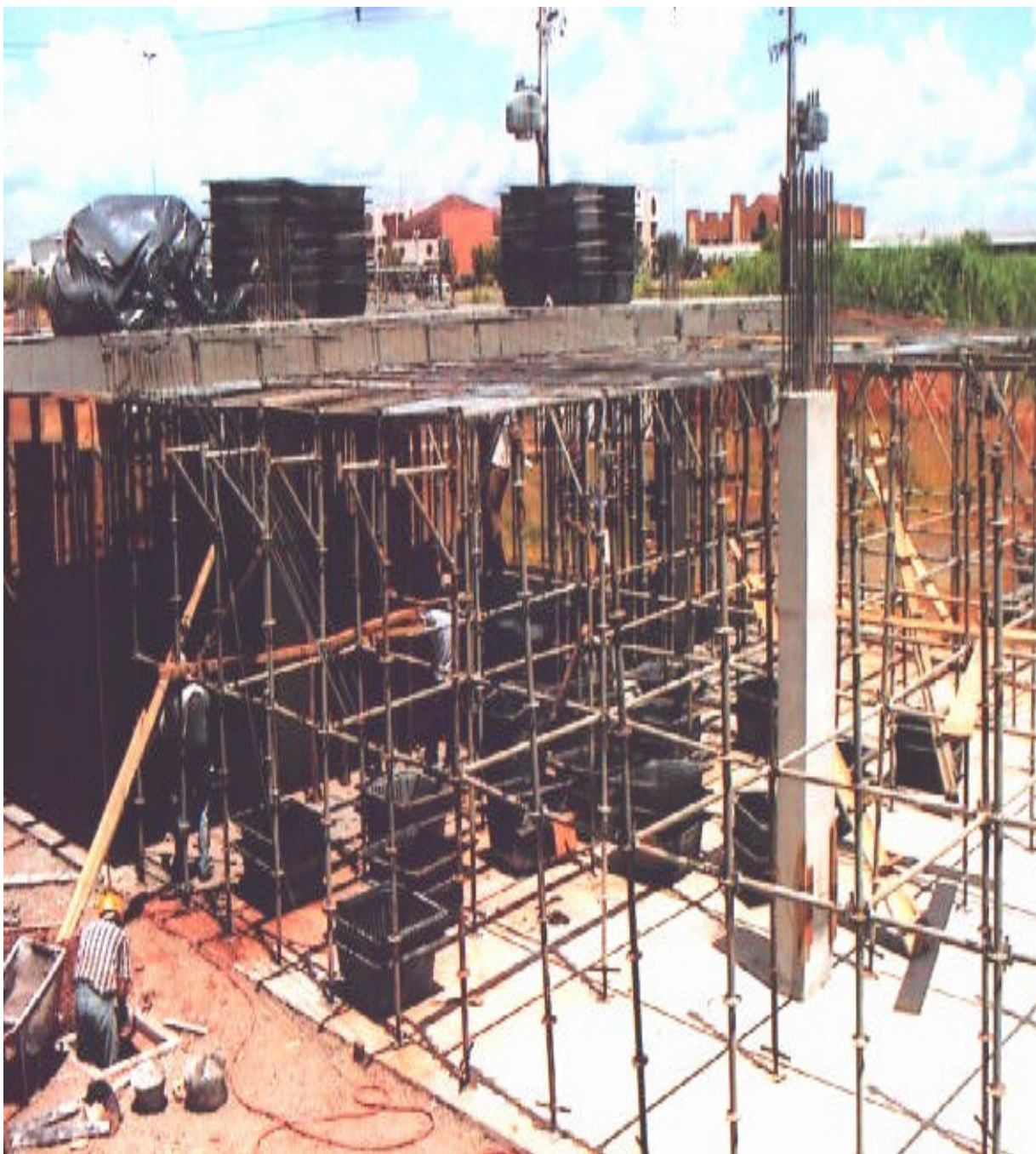
Figura 6: Pontaletes metálicos Fonte: Base de dados da UNIAMÉRICA.
