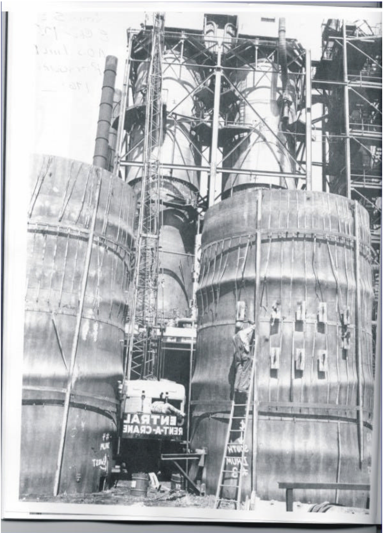
Figura 9: Tambor de coque com deformações no costado retirado de operação.[4]
