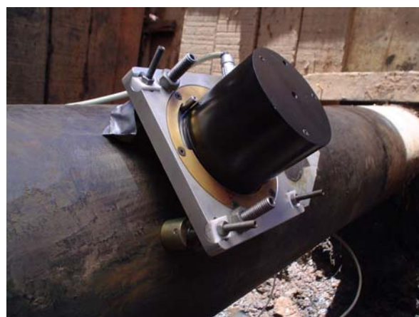
Figura E.14 Medição em campo do MTRES Modular em dutos
