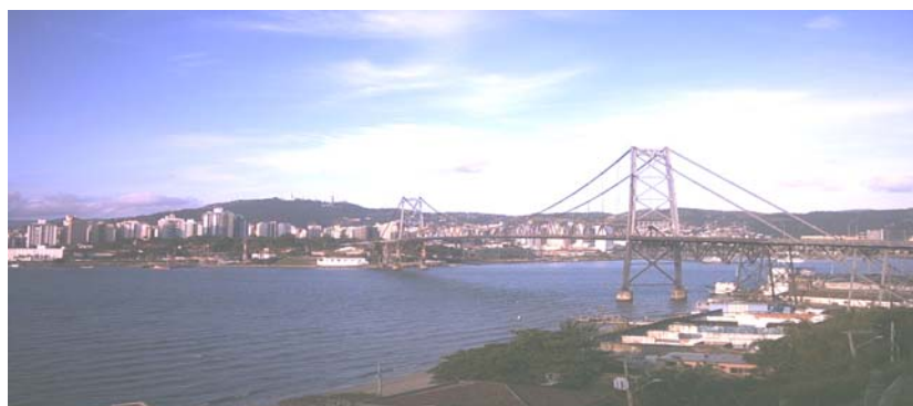
FIGURA 11 – Ponte Hercílio Luz
