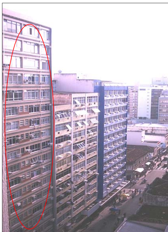
FIGURA 12 – Edifício Dias Velho
