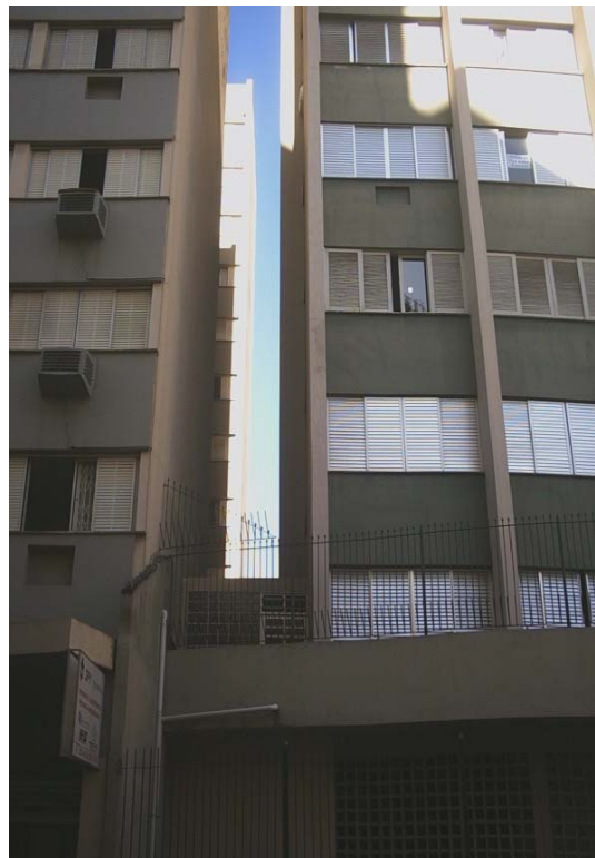
FIGURA 20 – Afastamento entre edifícios com mais de 10 pavimentos
