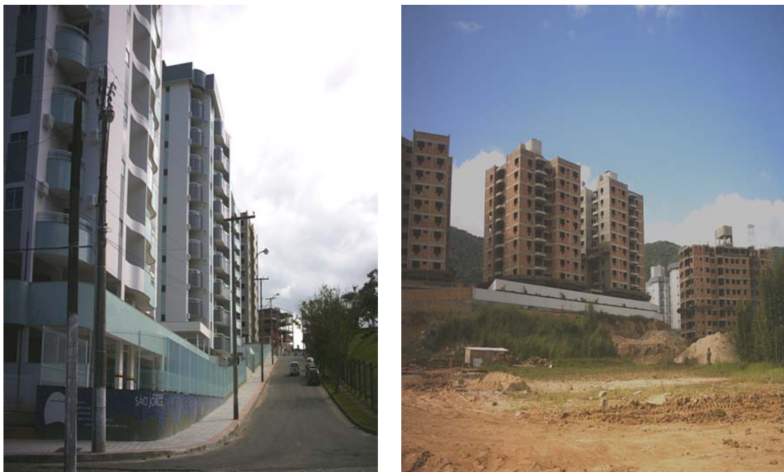
FIGURAS 43 e 44 – Verticalização no Parque São Jorge
