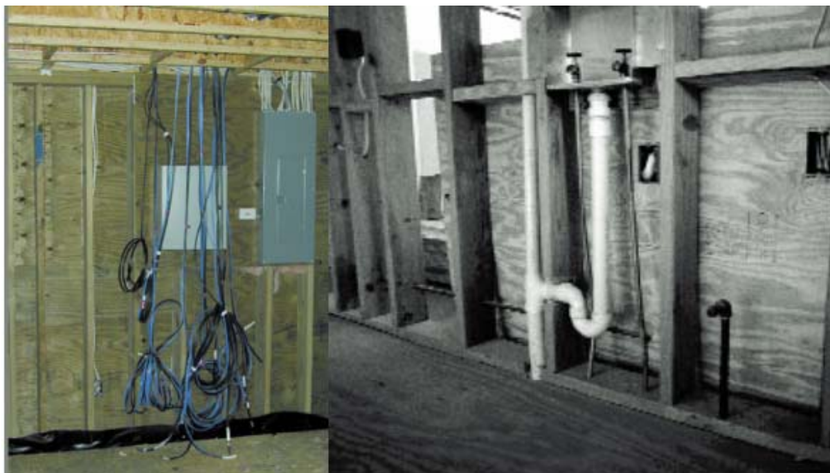
Figura 4 – Instalação do sistema elétrico e hidráulico. Fonte: SOUTHERN PINE COUNCIL (1999).
