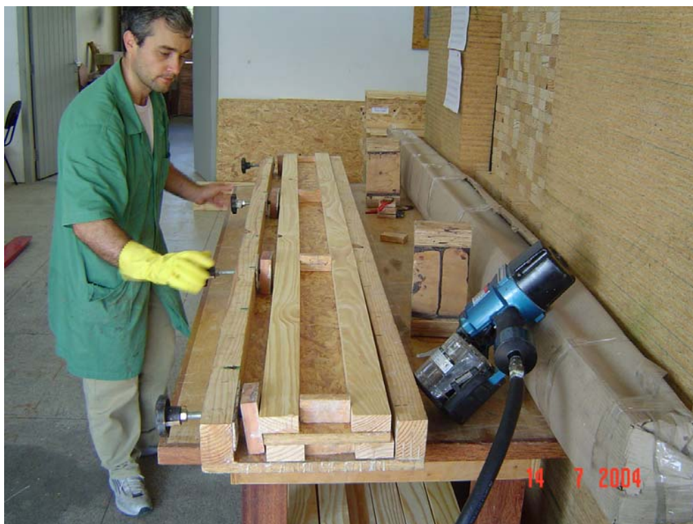
Figura 31 – Montagem e ajuste da viga-I com auxílio de gabarito.
