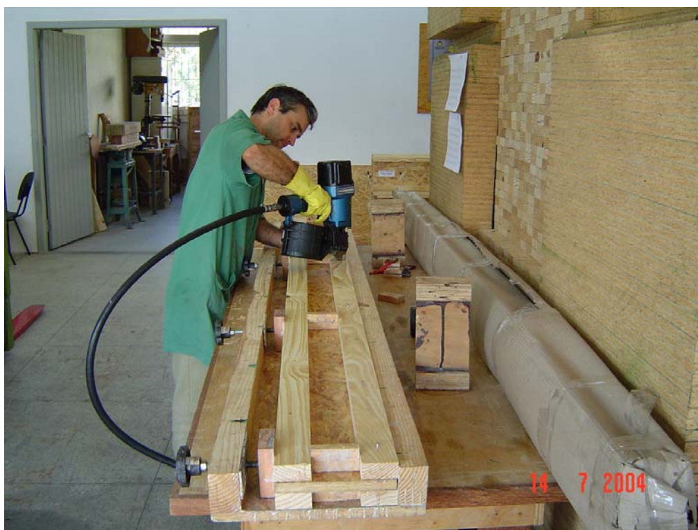
Figura 32 – Fixação das mesas da viga-I com auxílio de pregadeira pneumática.
