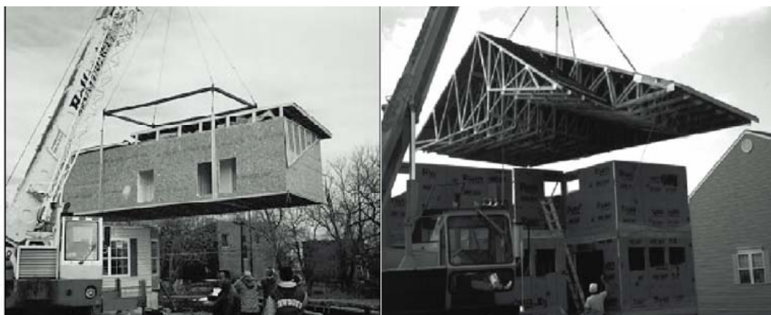
Figura 3 – Transporte e Içamento de Estruturas Executadas fora do Canteiro de Obra. Fonte: PATH (1998).
