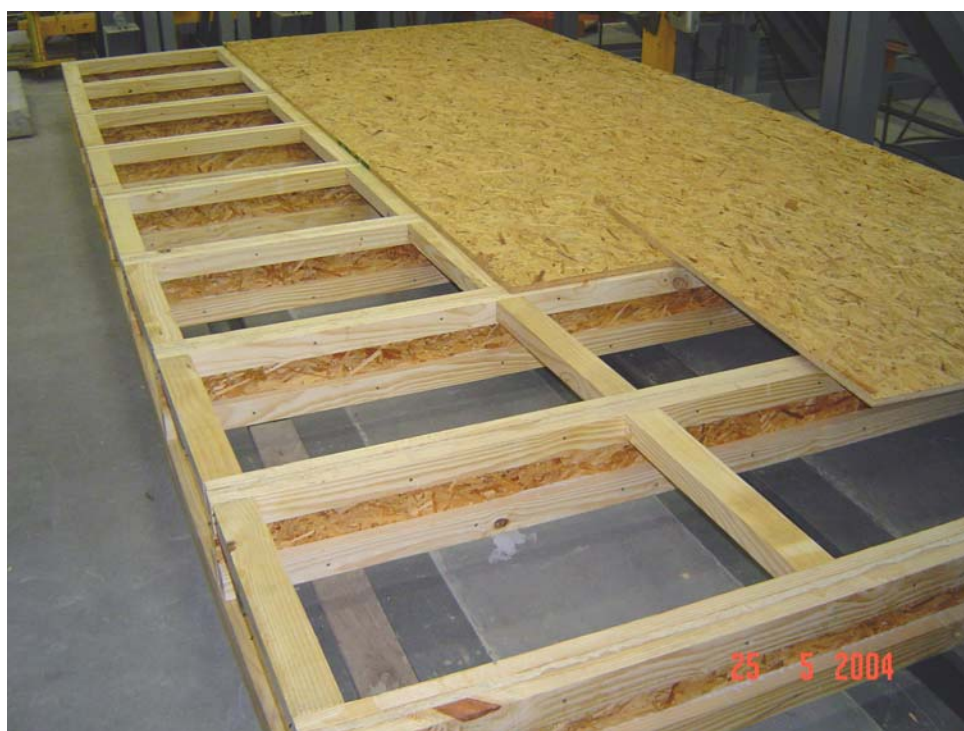
Figura 40 – Detalhe da fixação das chapas de osb nos enrijecedores e nas vigas-I.
