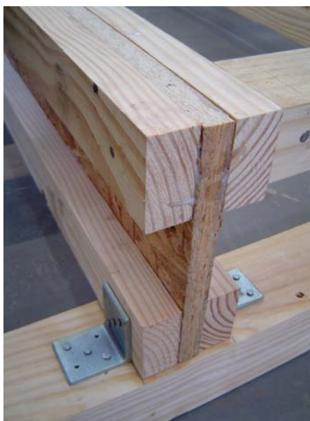
Figura 36 – Representação da Fixação das Cantoneiras.
