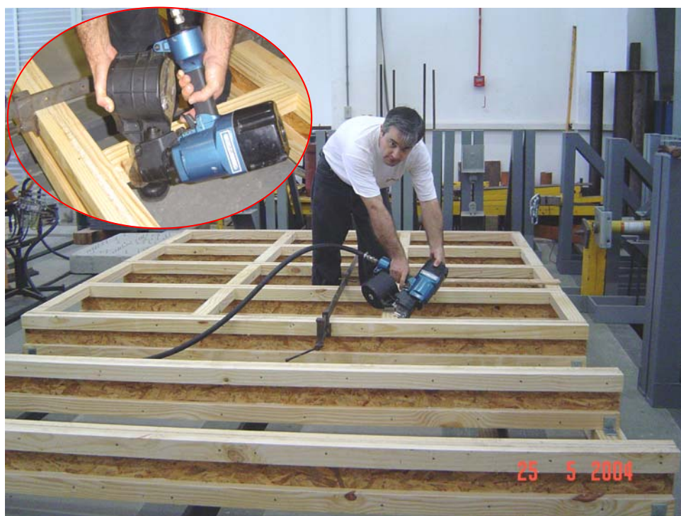
Figura 38 – Fixação dos elementos enrijecedores nas vigas-I.
