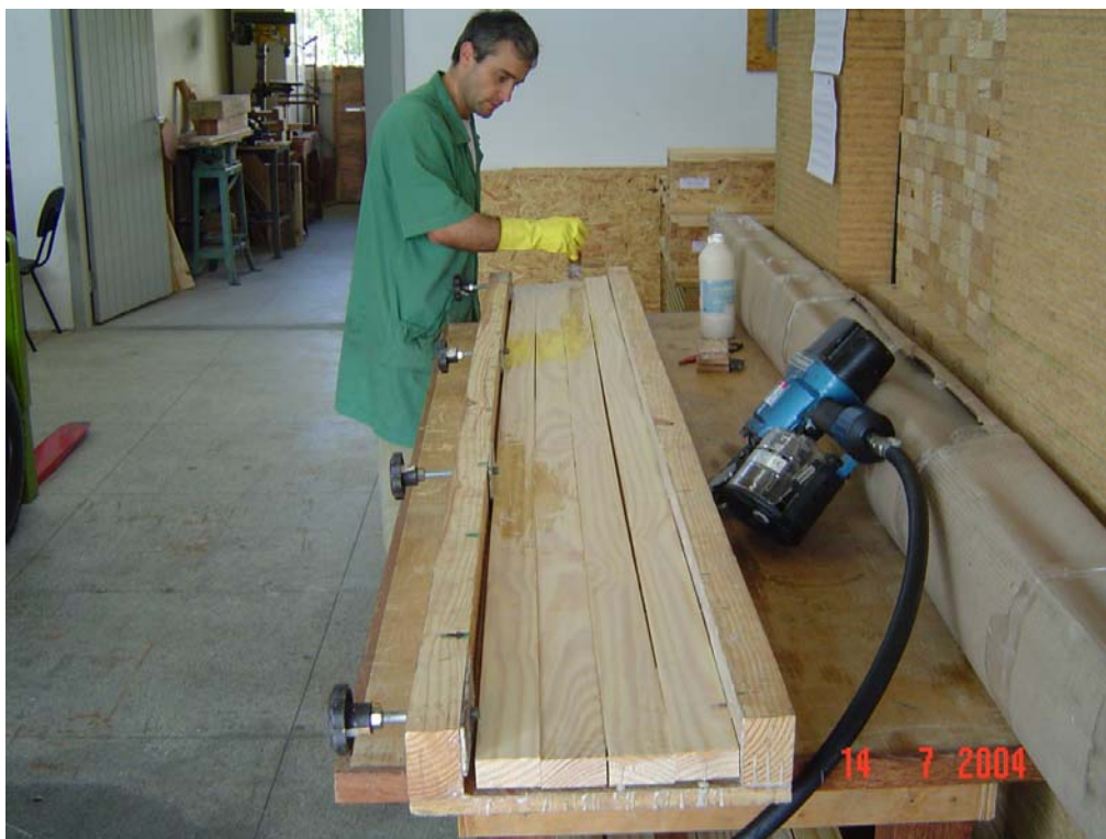
Figura 30 – Aplicação e distribuição do adesivo nas mesas.
