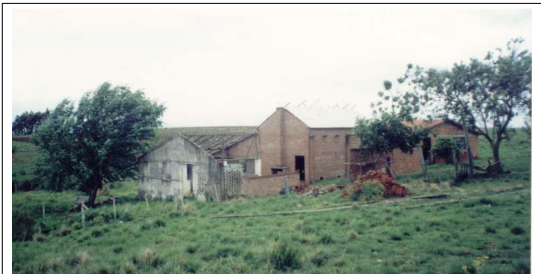
Figura 22: Estufa de fumo em construção – Assentamento Renascer. Nov/2003.
