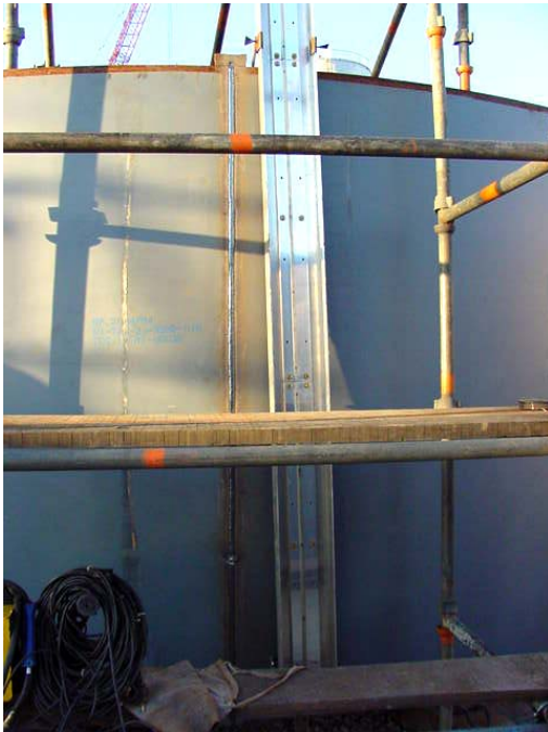
Figura 4.29 - Cordão de solda.
