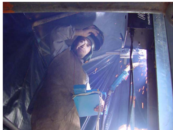
Figura 4.28 - Operador realizando a soldagem.
