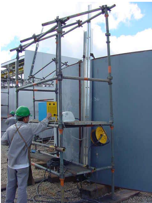
Figura 4.26 - Instalação do trilho.
