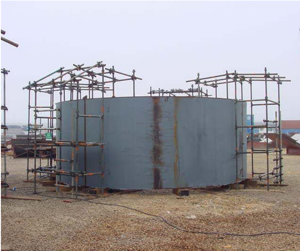
Figura 4.23 - Anel com os andaimas prontos para a realização das soldas.
