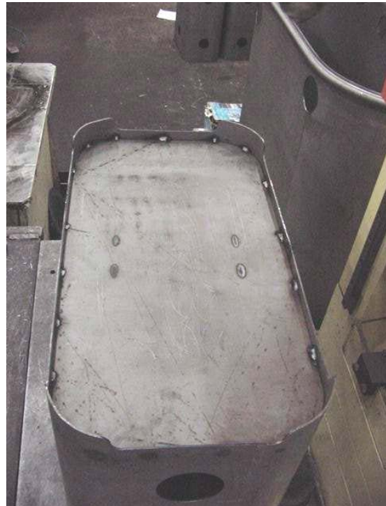
Figura 4.36 - Solda a ser realizada.
