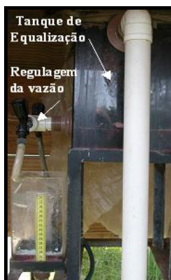
Figura 5: Unidade de medição de vazão afluente à lagoa facultativa.
