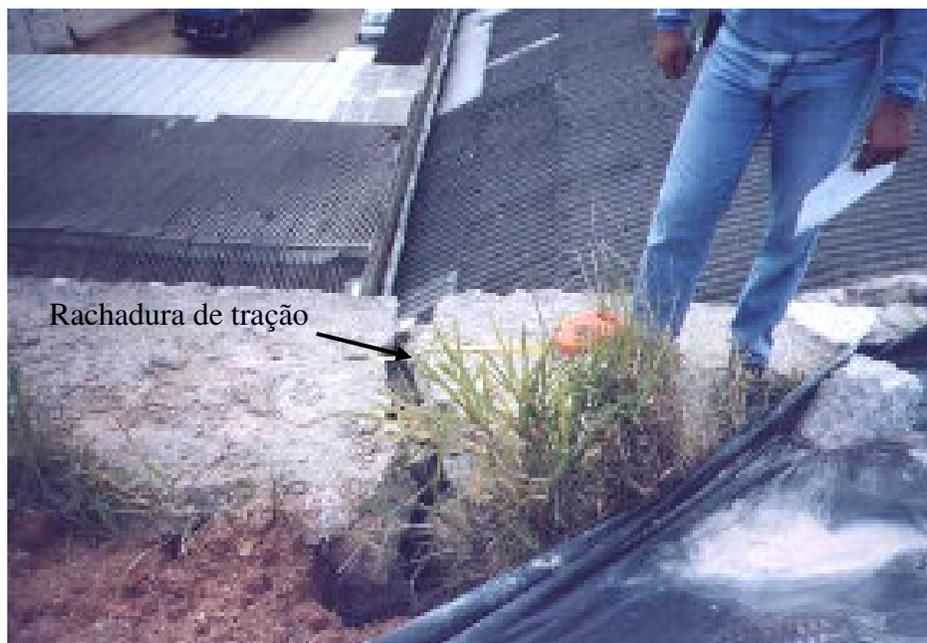
Foto 7.1 – Trinca no Muro de Gravidade.
