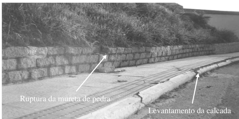
Foto 6.5 – Levantamento da calçada e ruptura da mureta de pedras.
