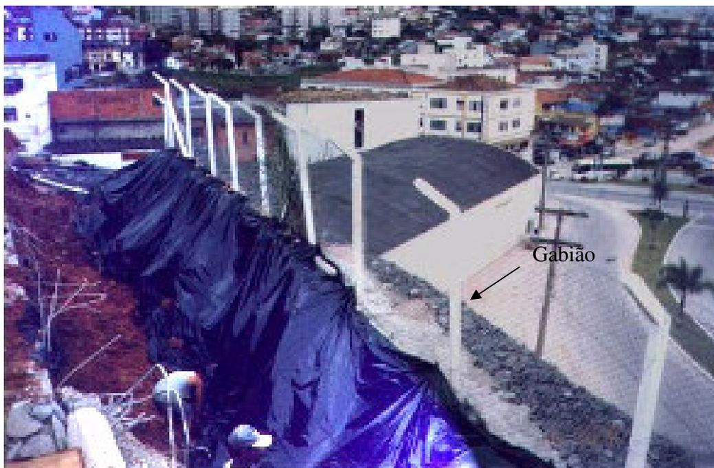
Foto 7.3 – Escavação da parte superior da estrutura Terramesh®.
