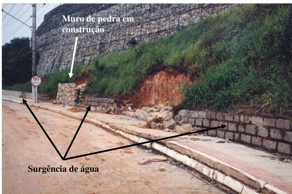
Foto 11.2 – Pontos de surgência de água na base da estrutura Terramesh®.
