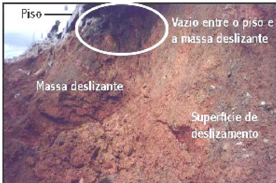
Foto 7.7 – Superfície de deslizamento.
