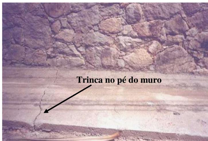
Foto 11.3 – Trincas no pé do muro de pedra.
