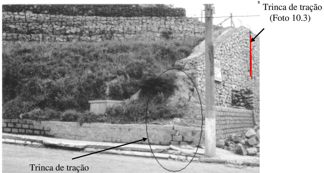
Foto 10.2 – Trinca de tração no Muro de Gravidade.
