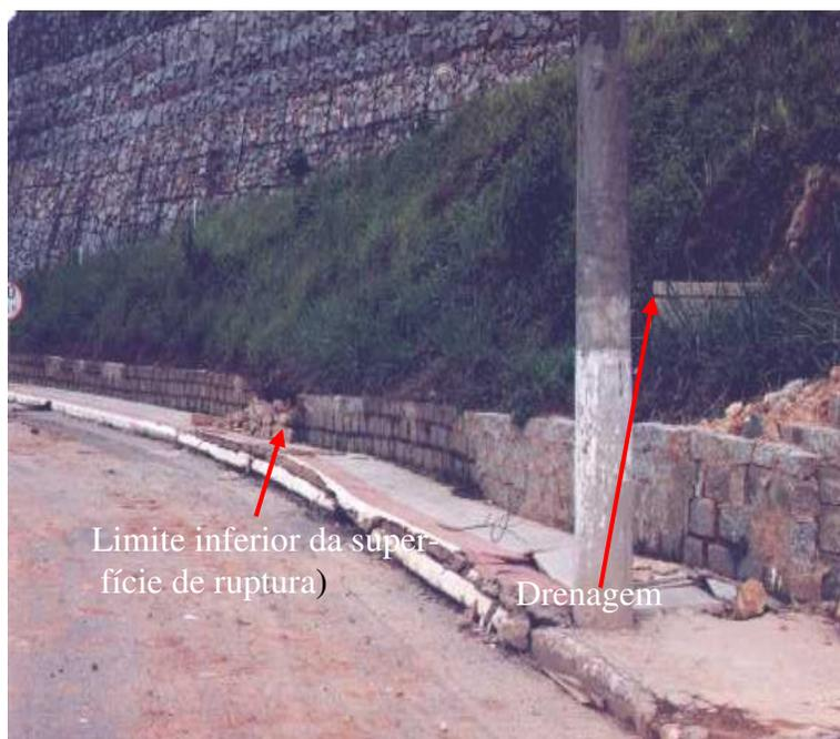
Foto 7.5 – Levantamento da calçada e do asfalto.
