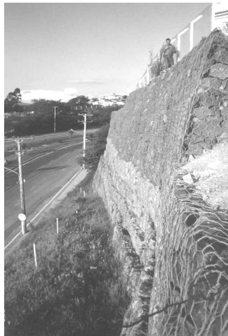
Foto 6.3 – Deformação do paramento da estrutura Terramesh®.
