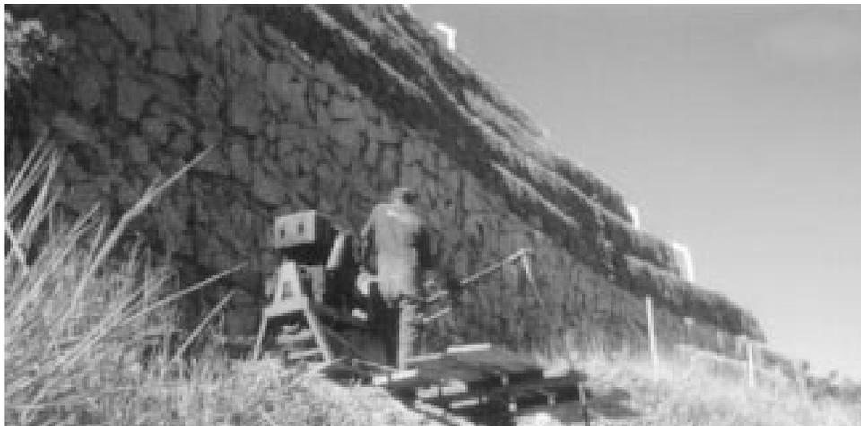
Foto 6.4 – Deformações em arco e falta de alinhamento do paramento externo (Gabião).
