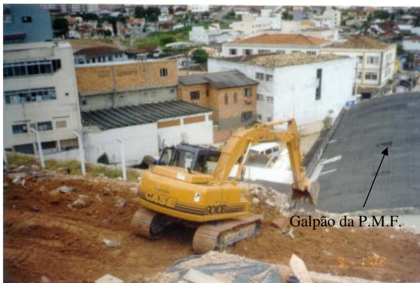
Foto 7.2 – Máquina escavando no topo do Muro de Gravidade.
