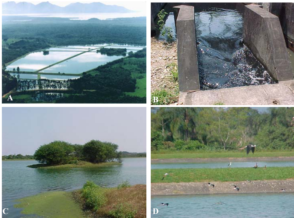
Figura 4. A) Vista geral da ETE–Jarivatuba. B) Entrada do Esgoto Bruto; C) Lagoa Facultativa (F1); D) Lagoas de Maturação (M22 e M32).
