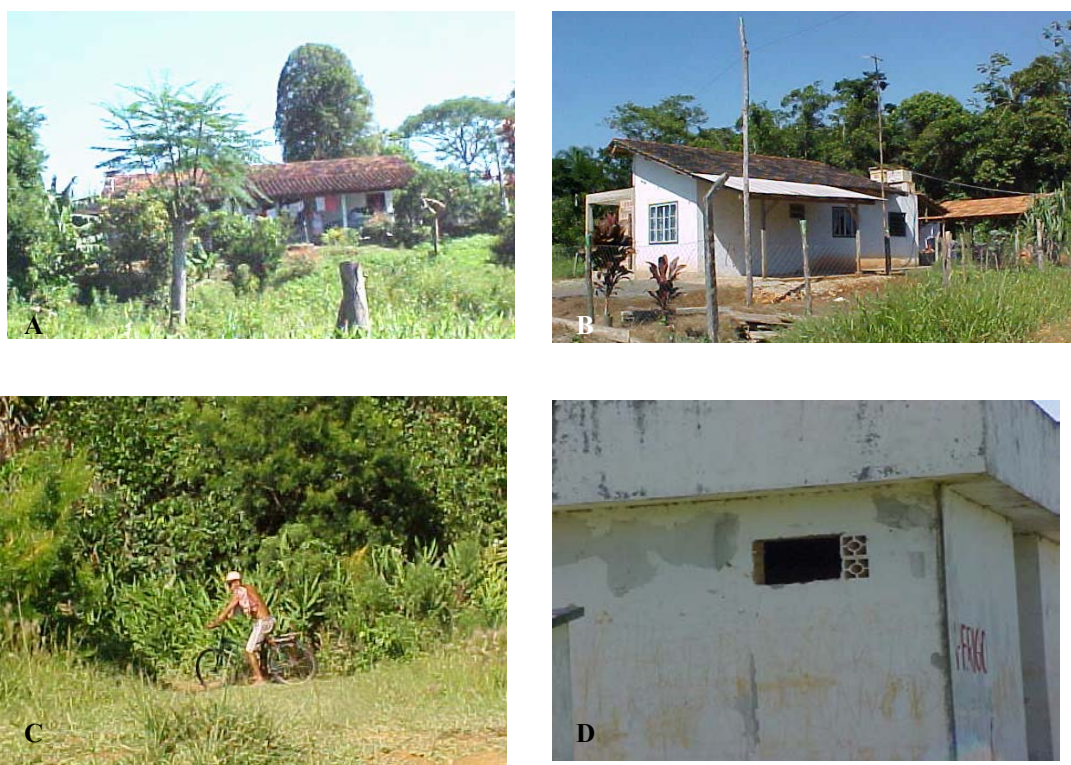
Figura 8. A e B) Residências cujo acesso único é pela área da ETE; C) Morador do entorno cortando caminho por trilhas abertas dentro da propriedade da ETE; D) Casa de bombas para recirculação depredada pela ação de vândalos.
