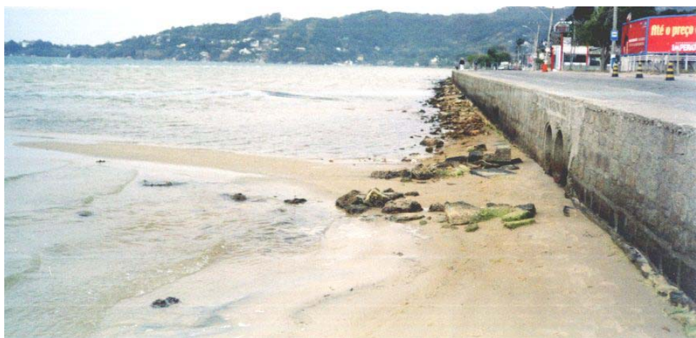
Figura 65: Detalhe do muro de contenção. Notar a presença de algumas barras transversais, que existem apenas nesse ponto.
