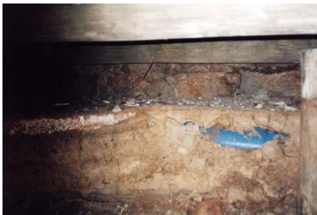
Figura 69: Detalhe de erosão sob a passarela. A ação de ondas não possibilita a acumulação de depósitos sedimentares.
