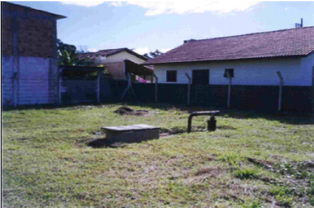
Figura 21. Poço de abastecimento público situado a menos de 10 metros de uma casa (sem coleta e tratamento de esgoto). Distrito do Rio Vermelho, Ilha de Santa Catarina. Foto: do Autor.
