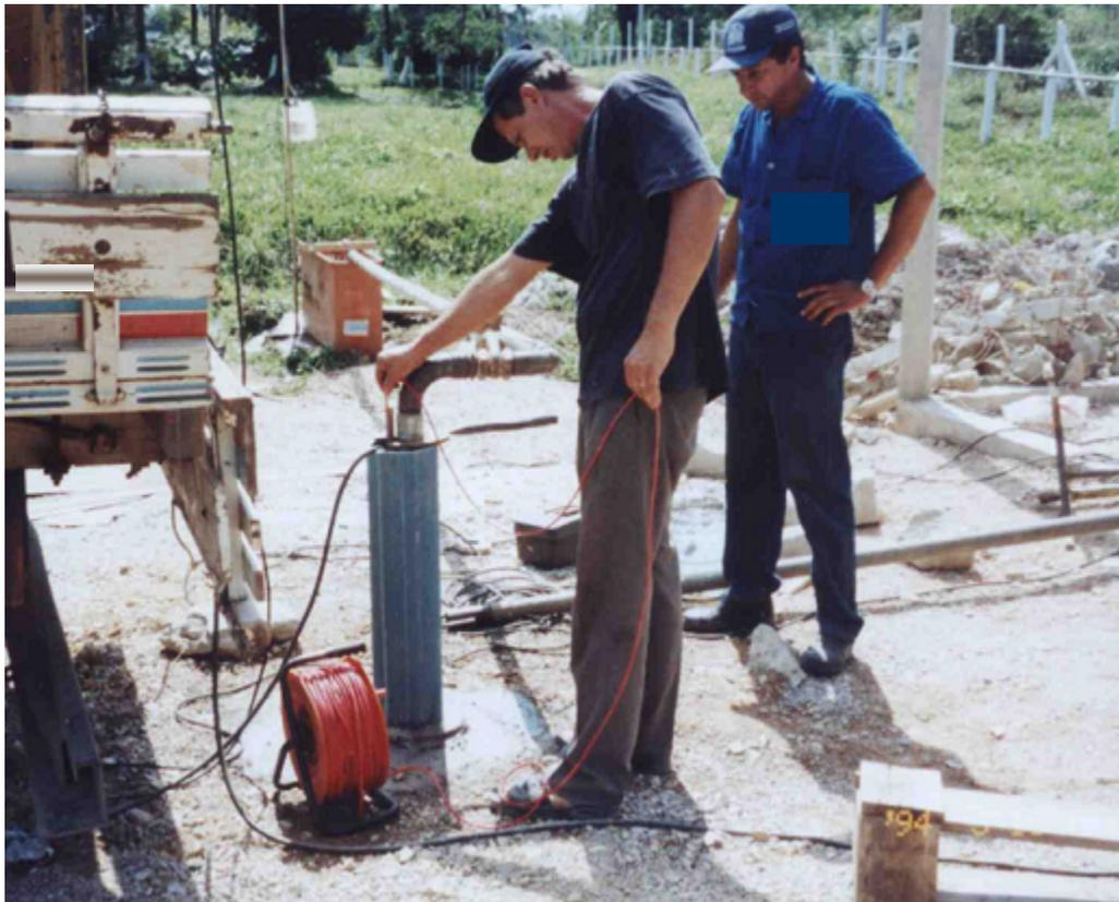
Figura 28. Medida do rebaixamento do Poço 1. Foto: do Autor.
