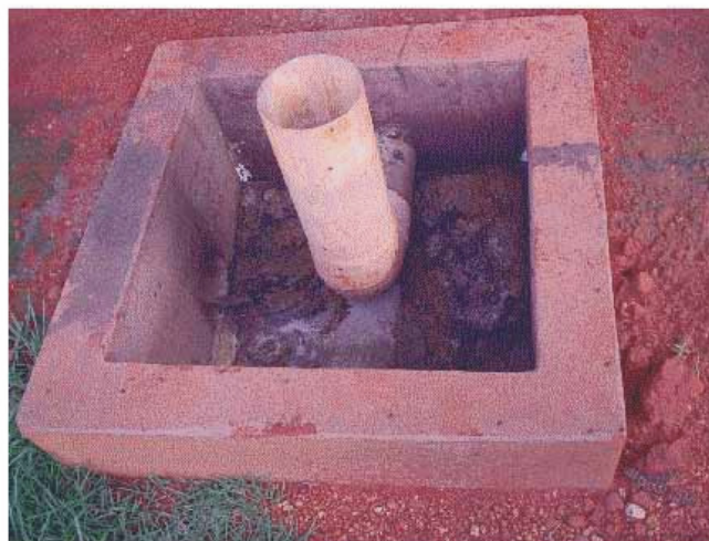
Figura 4.9 –Detalhes da tubulação de escoamento.
