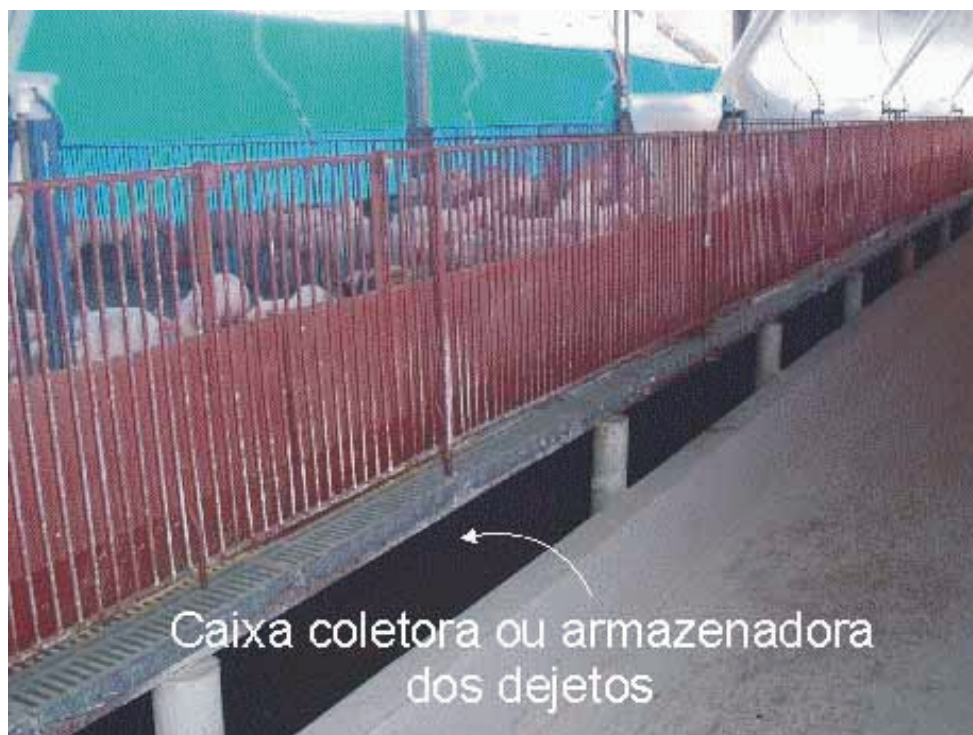
Figura 4.6 - Instalações da creche indicando a caixa coletora dos dejetos.
