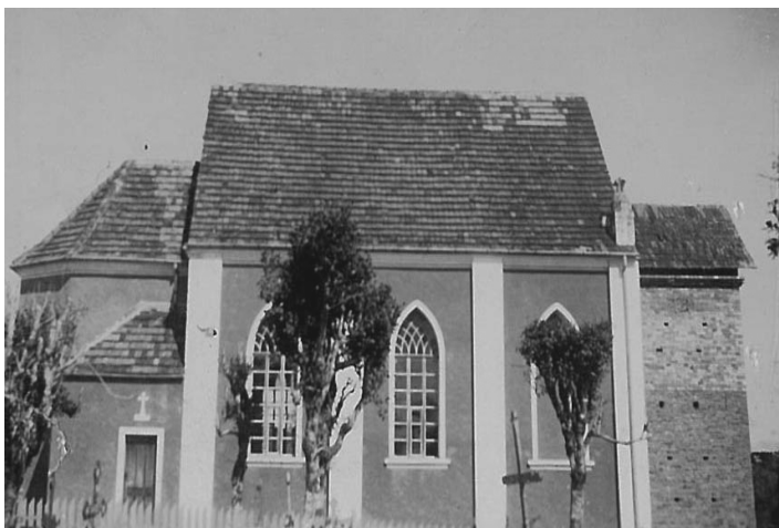
Figura 27- Capela de alvenaria - Bateias
