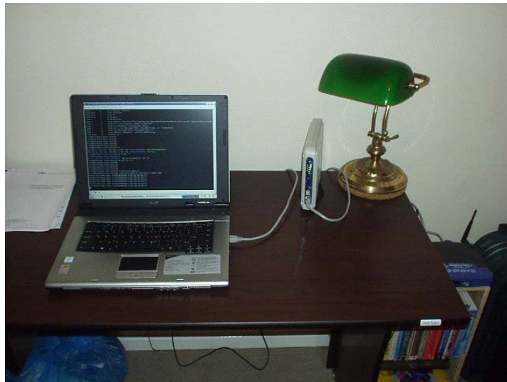
Figura 5.1 - MODEM PLC (cliente) instalado no cenário residencial
