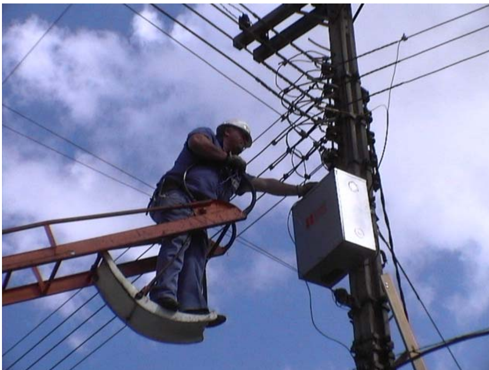
Figura 2.7 - Instalação do equipamento primário (Master) PLC.
