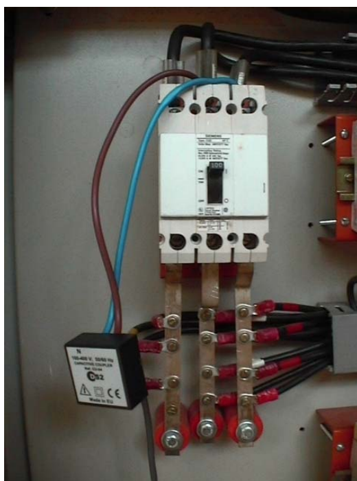
Figura 2.10 - Detalhe do acoplador capacitivo para redes de baixa tensão (até 1kV).
