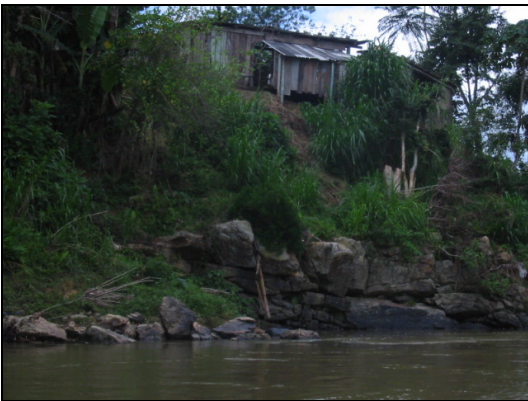
Figura 48: Casas às margens do Itajaí-Mirim.
