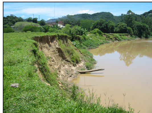
Figura 45: Erosão no Rio Itajaí-Mirim.
