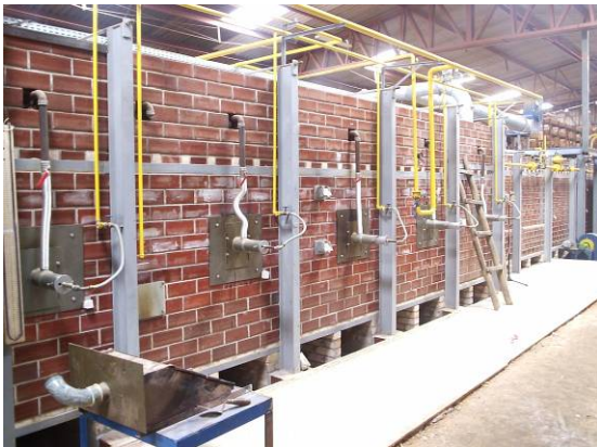
Figura 3.9: Vista lateral da zona de queima, com o sistema de queima de gás natural.
