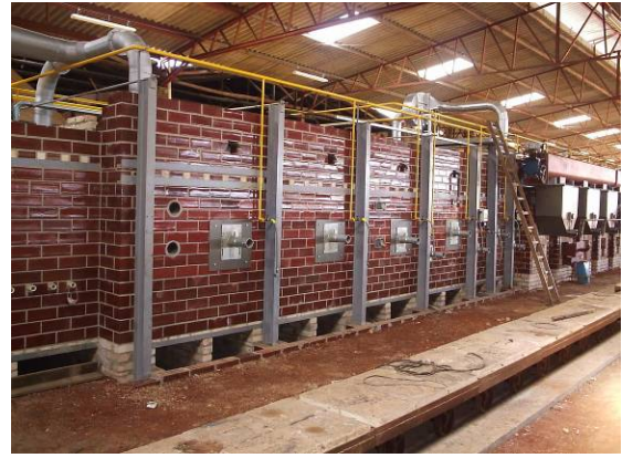
Figura 3.4: Vista geral da zona de queima, com a instalação dos queimadores de gás natural no primeiro plano, seguidos dos alimentadores de serragem ao fundo.
