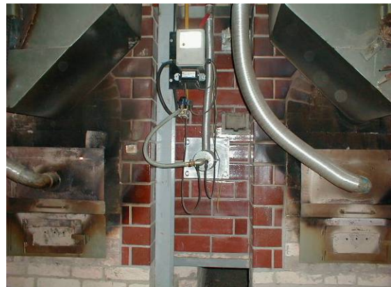
Figura 3.8: Queimador de gás natural atuante na parte inferior da carga, colocado entre as fornalhas de serragem.
