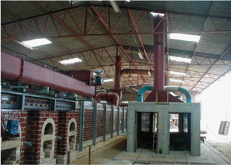
Figura 5.14: Pré-aquecedor da carga utilizando os gases da chaminé de tiragem.
