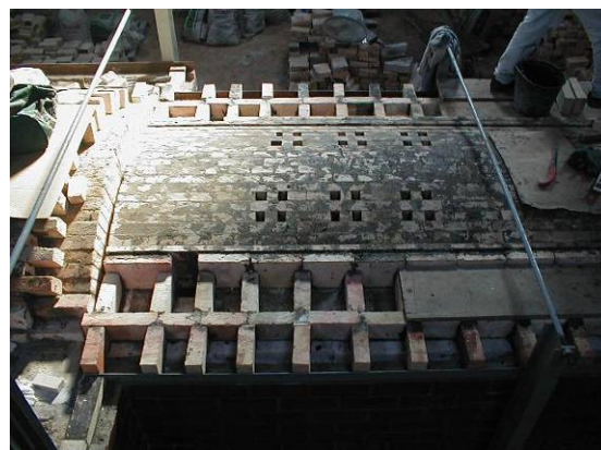
Figura 3.14: Aberturas na abóbada para a recuperação de calor proveniente do resfriamento rápido.
