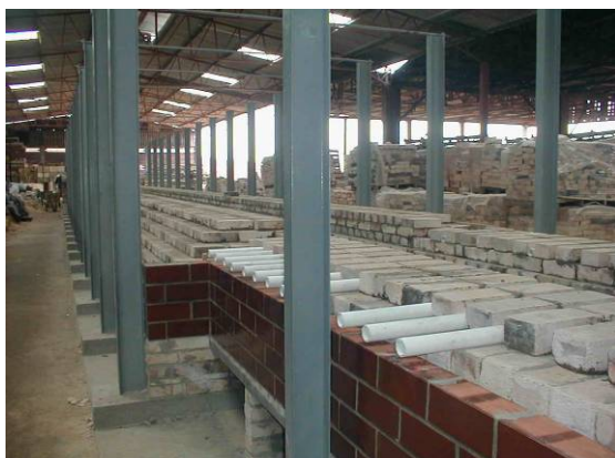
Figura 3.13: Colocação dos tubos de injeção de ar frio no resfriamento rápido.
