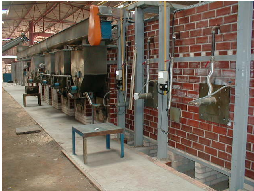
Figura 4.8: Lateral do forno mostrando a queima a gás no primeiro plano e a queima de serragem ao fundo.
