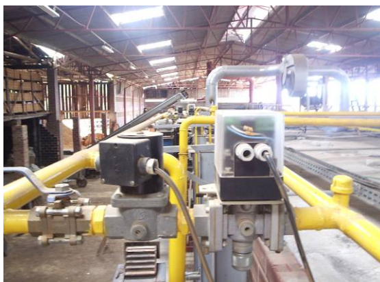
Figura 3.11: Válvulas para o controle da vazão de gás natural para os queimadores laterais.
