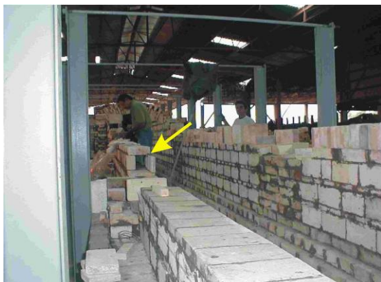
Figura 3.15: Construção dos canais na parede do forno, para o resfriamento indireto.
