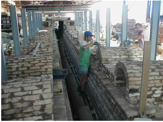
Figura 3.3: Construção da zona de pré-queima, com as fornalhas para queima de serragem.
