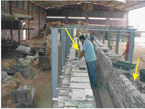
Figura 3.1: Construção do pré-aquecimento, com os canais de tiragem na parede.
