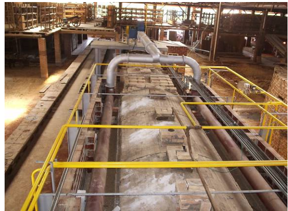
Figura 3.10: Instalação do ar de combustão para o gás natural antes do isolamento da abóbada.
