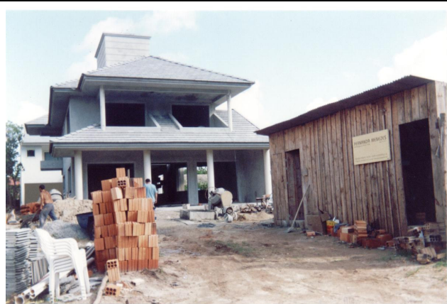
Residência em construção
