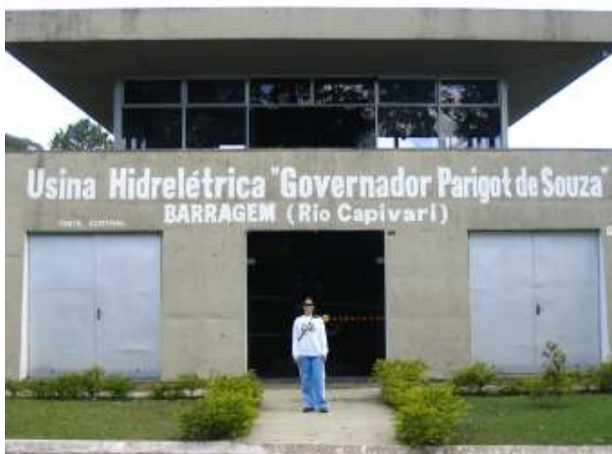
Figura 14 – Centro de controle da Usina Hidrelétrica “Governador Parigot de Souza – Barragem”
