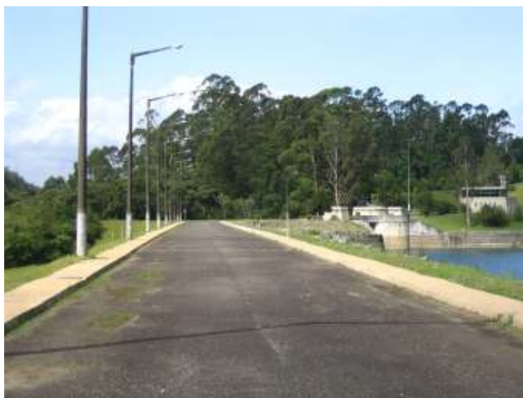
Figura 28 – Barragem da Usina Hidrelétrica “Governador Parigot de Souza”
