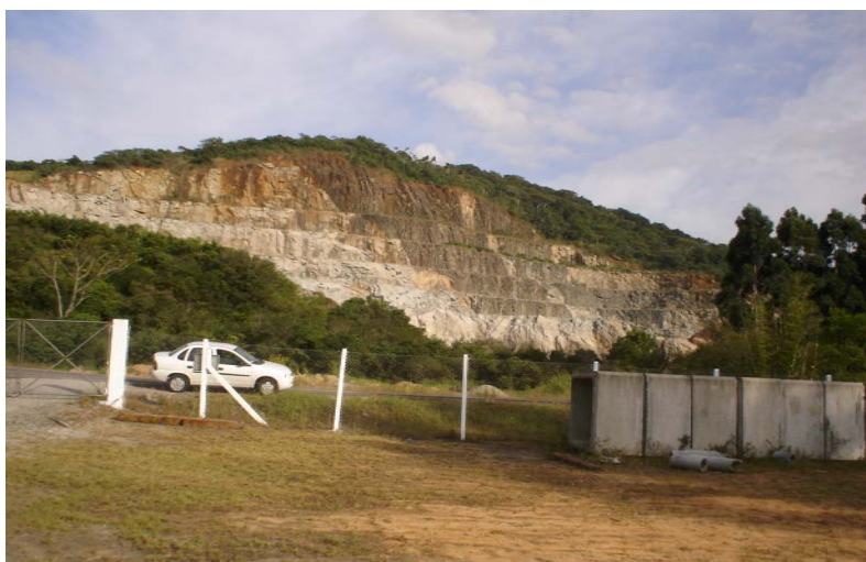
Figura 13 – Jazida da empresa Pedrita Planejamento e Construção Ltda.
