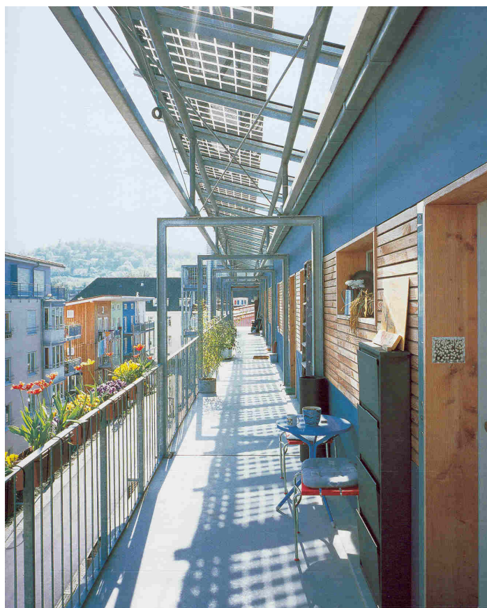
Figura 54. Painéis fotovoltaicos integrados na passarela. Edifício Habitat e Trabalho. Friburgo, Alemanha. Arqs. Common & Gies 131 .
