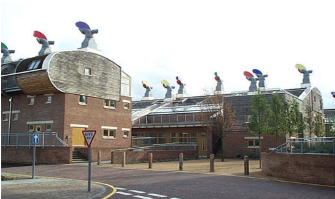
Figura 21. Área entre blocos 40 .
