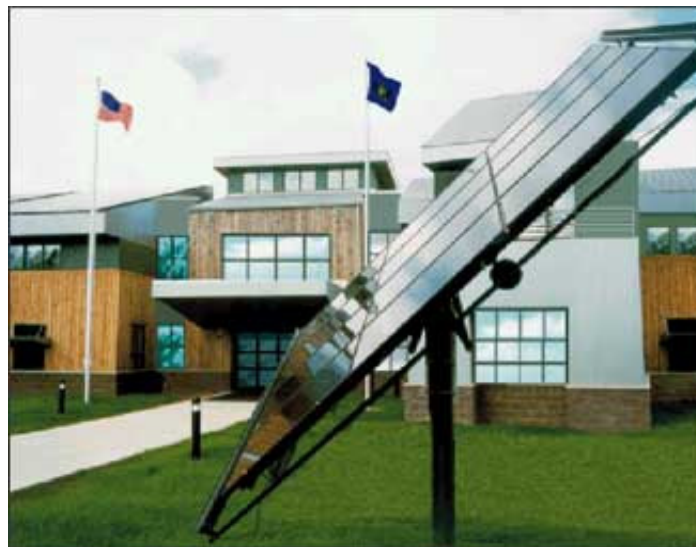
Figura 35. Edifício de escritórios Cambria em Edensburg, PA. Construído pelo Departamento de Proteção Ambiental de Pensilvânia. USA. Ganhador do LEED Ouro, na versão 2.0 73 .
