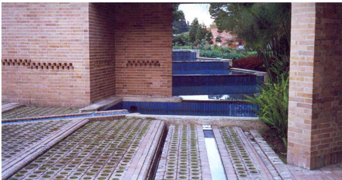
Figura 50. Exemplo de pavimentação de grade aberta. Projeto Edifício de Pósgradados da Universidade Nacional. Bogotá. Colômbia. Arq. Rogelio Salmona 119 .
