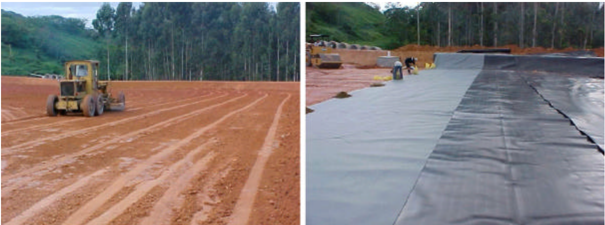
Figura 2.2 – Sistema de impermeabilização de base sendo construído em um aterro sanitários
