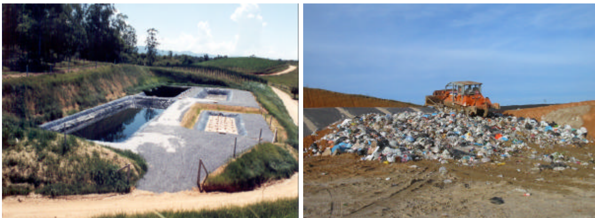
Figura 6.1 – Tratamento de percolados e compactação de resíduos no aterro do Município de Timbó. FONTE: O autor
