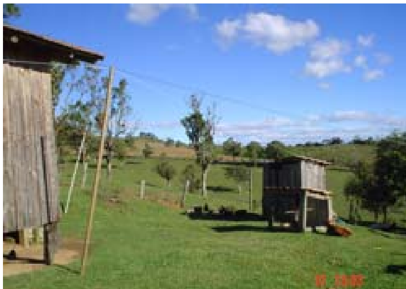
Foto 1 - Banheiro localizado atrás da residência da mãe D, 26 anos e um filho de 4 anos.
