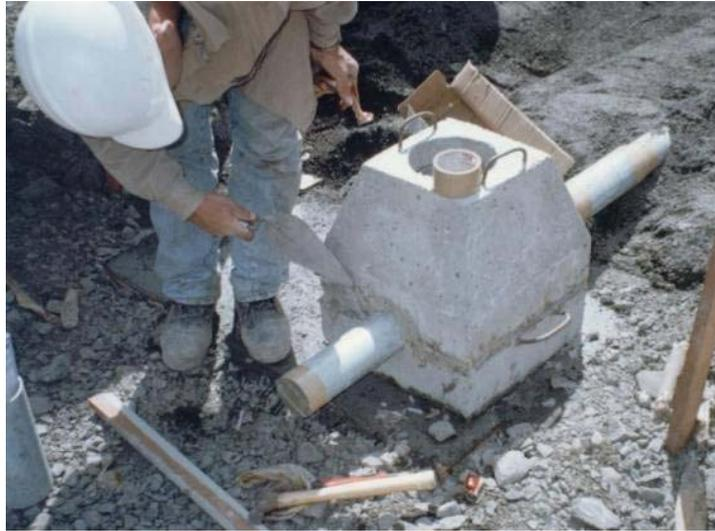
Figura 2-18 – Instalação de uma Caixa Sueca.
