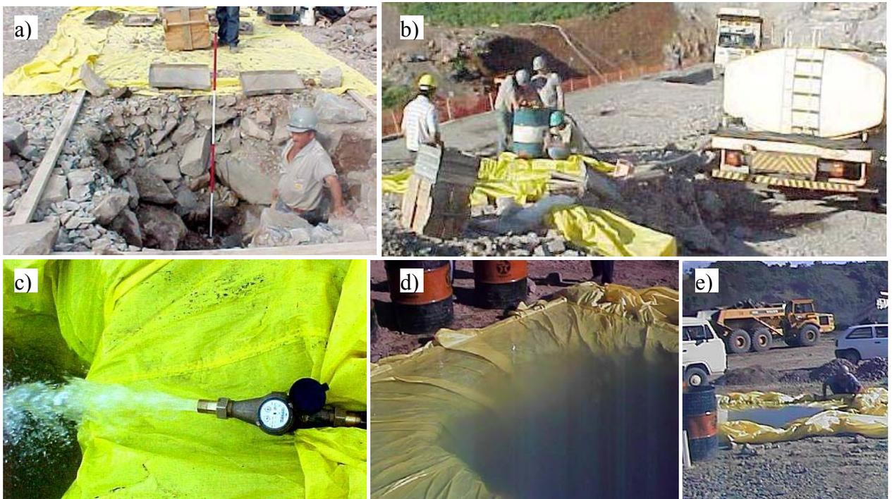
Figura 5-6 – Execução do ensaio de peso específico em campo.
