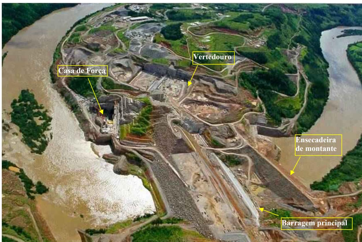
Figura 5-2 – Vista geral da UHE Machadinho no período construtivo.
