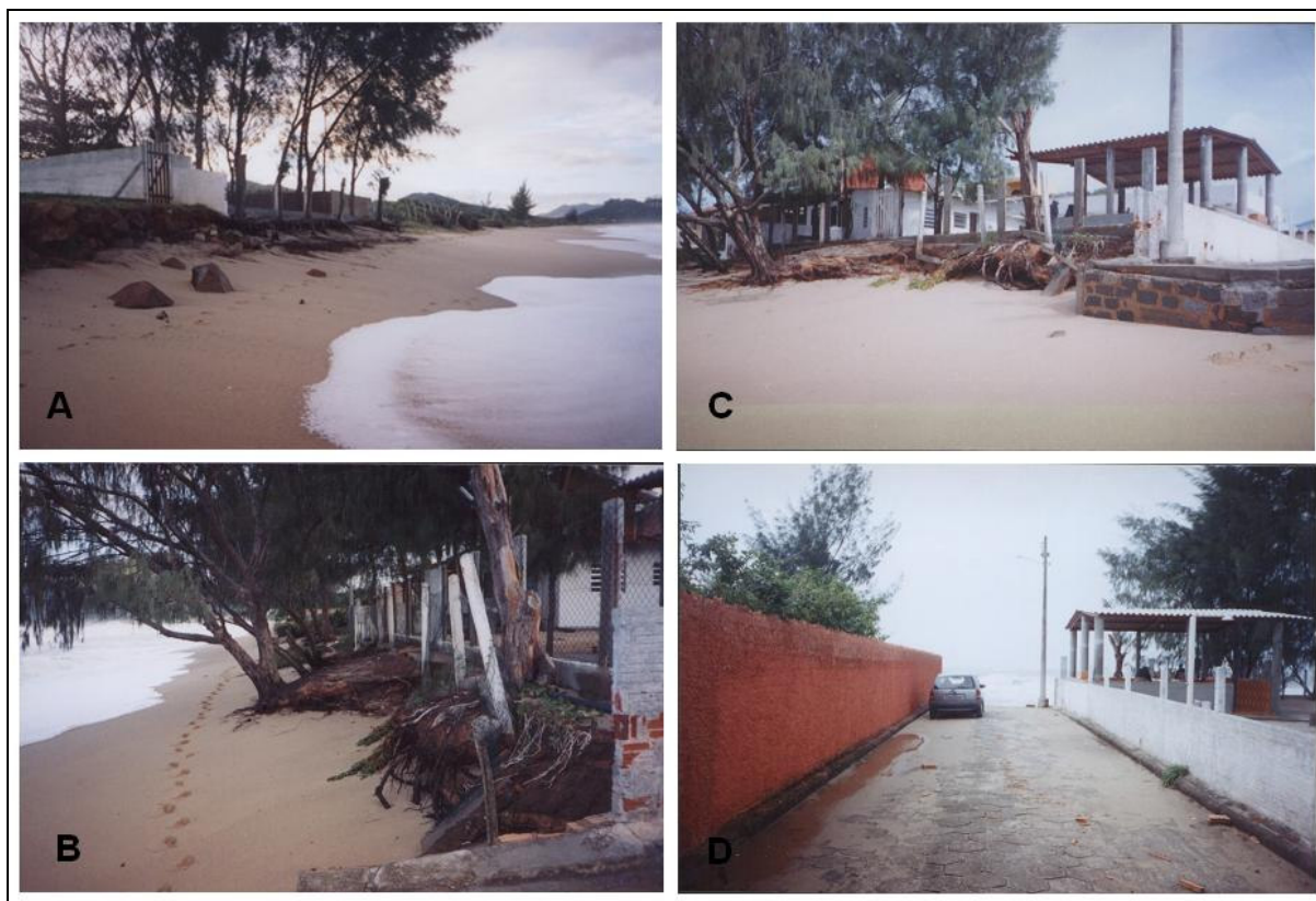
FIGURA 64 – Evidências de erosão e inundação na Praia da Armação após o ciclone de 09/08/05.
