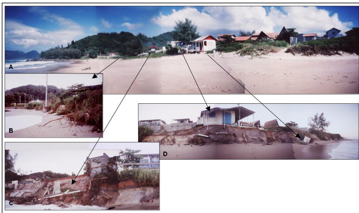
FIGURA 63 – Mosaico das fotografias obtidas em março de 2004 (A), e em detalhe os danos causados após o evento erosivo de junho de 2004 (B, C e D).
