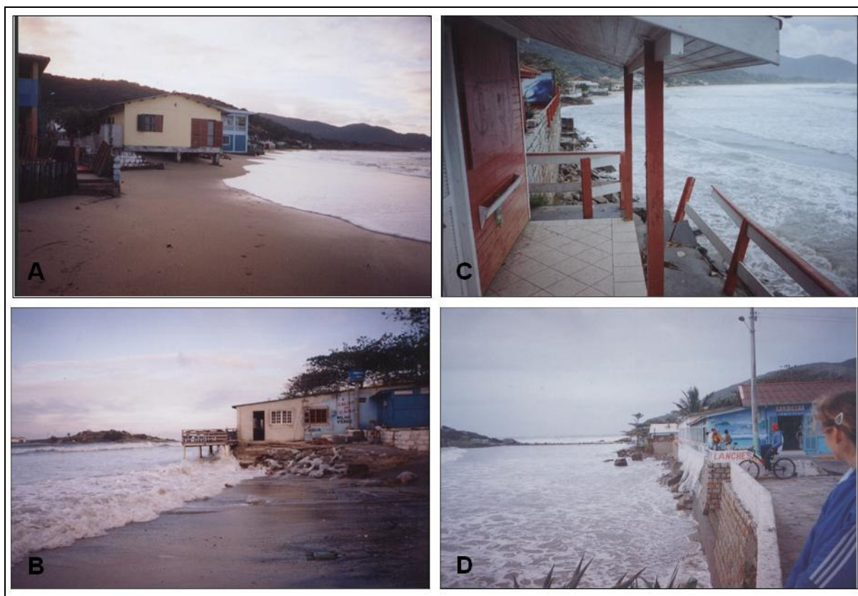
FIGURA 65 – Evidências de erosão e inundação na Praia da Armação após a o ciclone de 09/08/05.
