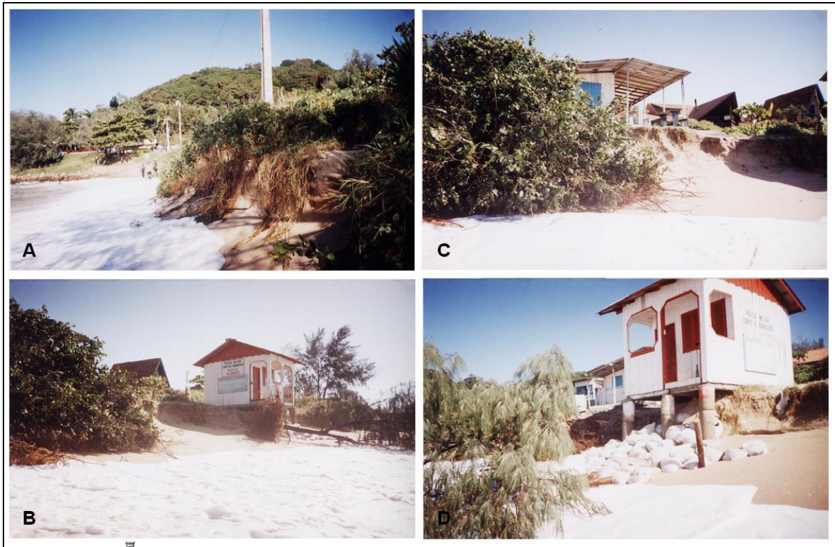
FIGURA 62 – Evidências erosivas na Praia Morro das Pedras após a o ciclone de 26/05/04.
