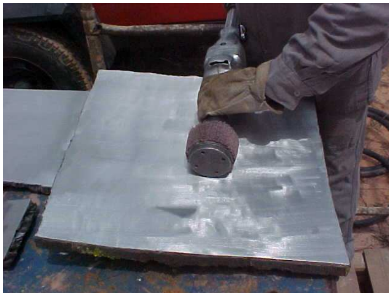
Figura 4.2: Polimento dos CP'S conforme PMEH 3, após recuperação com solda.
