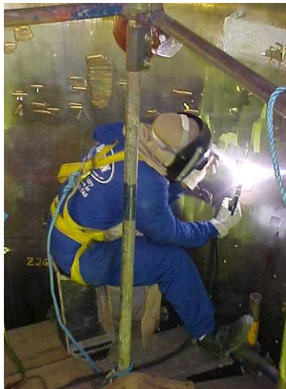
Figura 4.41: Detalhe da recuperação de pites isolados com TIG-P, processo usado em recuperação de pequenas áreas isoladas.
