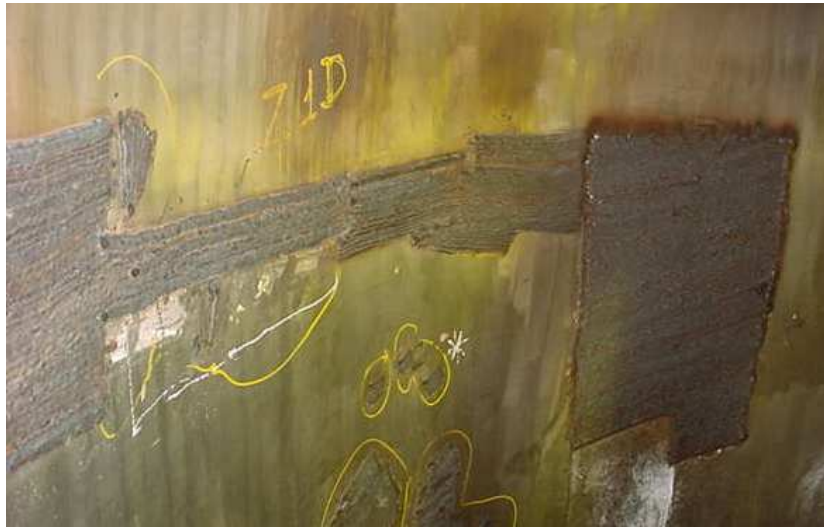
Figura 4.40: Aspecto do costado após a recuperação de pites agrupados com MIG-P, processo usado em recuperação de grandes áreas.
