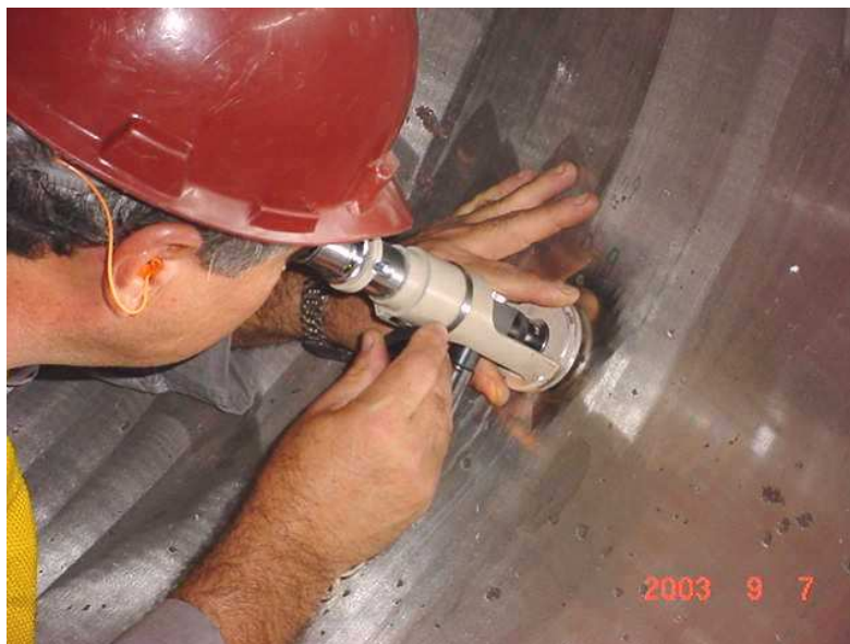
Figura 4.46: Detalhe do ensaio por réplicas metalográficas após a recuperação de pites.
