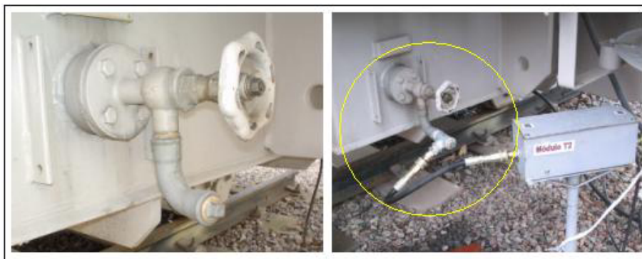
Figura 6-2 - Adaptação realizada na válvula de dreno do transformador
