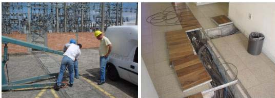
Figura 6-3 - Lançamento do cabo de fibra óptica
