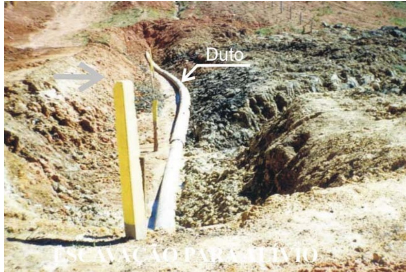
FIGURA 32 – Deslocamento do duto causado pela construção de aterro na lateral da faixa. Fonte: VASCONCELLOS et al. (2005).
