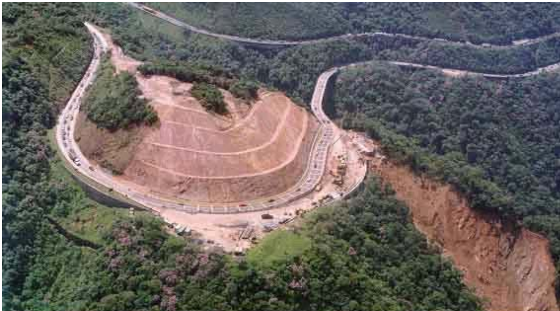
FIGURA 5 - Vista aérea do escorregamento do km 42 da rodovia Anchieta (SP)
