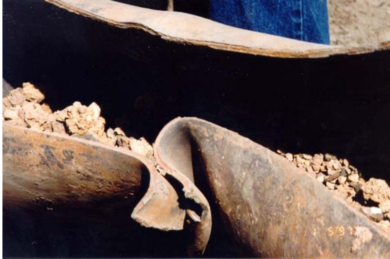
FIGURA 8 – Detalhe do “ buckle ” formado no duto após a ruptura. Fonte: TSB REPORTS, 2004.
