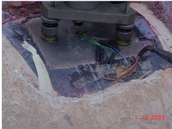
FIGURA 50 – Detalhe do aparato de perfuração e extensômetros colados no duto. Fonte: Arquivo TBG, 2004.
