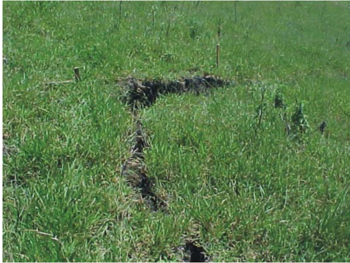
FIGURA 23 – Fenda de tração no terreno evidenciando rastejo ou escorregamento (Cerro Azul-PR). Fonte: Foto do autor, 2003.
