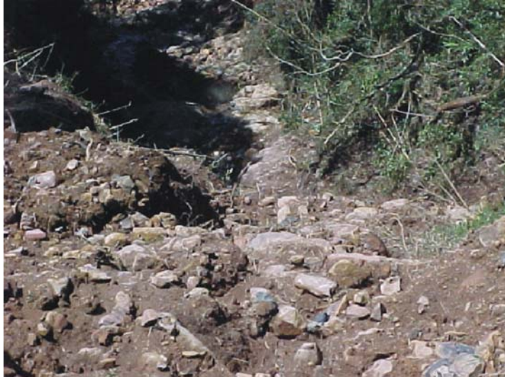
FIGURA 29 – Escorregamento superficial evidenciando corridas de massa ( debris flow ) (Timbó do Sul-SC). Fonte: Foto do autor, 2004.
