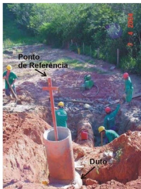
FIGURA 55 – Abraçadeira para monitoramento topográfico de dutos. Fonte: OLIVEIRA e VASCONCELLOS, 2005, p. 7.
