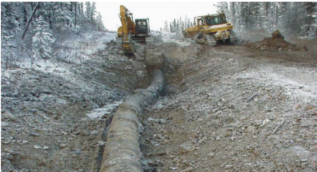
FIGURA 43 – Escavação do duto para alívio de tensões na região do escorregamento de Daniels Creek. Fonte: CZYZ e MCCLARTY, 2004.
