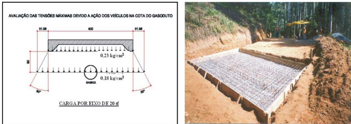
FIGURA 65 – Exemplo de laje de proteção para dutos. Fonte: VASCONCELLOS et al., 2005, p. 6.
