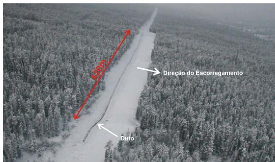
FIGURA 40 – Vista aérea do escorregamento de Daniels Creek após escavação do duto. Fonte: CZYZ e MCCLARTY, 2004 (com adaptações do autor).
