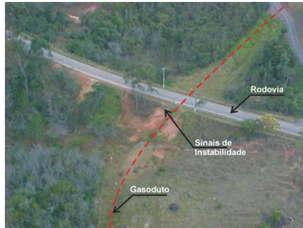
FIGURA 62 – Vista geral do talude instável junto a gasoduto. Fonte: OLIVEIRA e VASCONCELLOS, 2005b.
