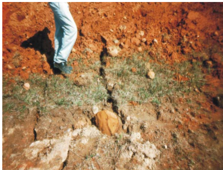
FIGURA 31 – Trincas indicando deslocamento do terreno junto a poliduto no Paraná. Fonte: VASCONCELLOS et al. (2005).
