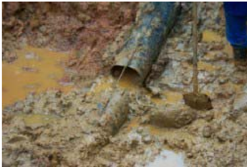
FIGURA 10 – Detalhe do ponto de ruptura do oleoduto por tensões de tração. Fonte: SOARES e MUSMAN, 2001.
