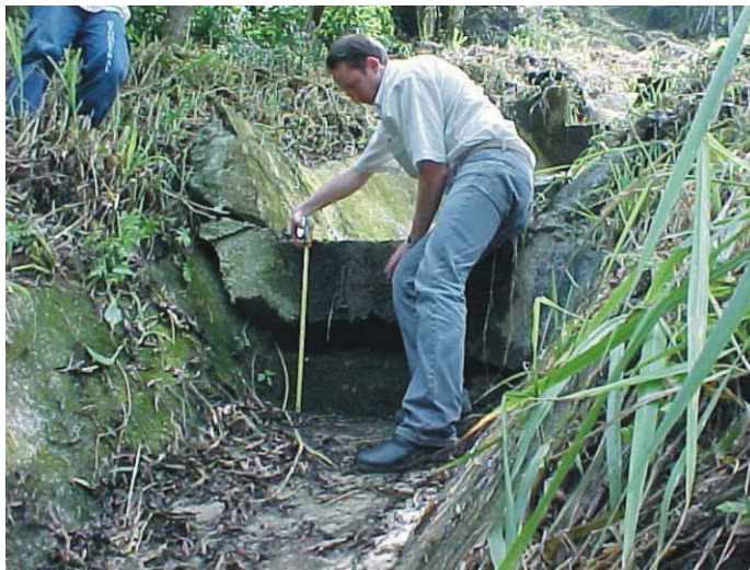
FIGURA 24 – Trinca em canaleta de drenagem evidenciando movimentos de massa (Rio Branco do Sul-PR). Fonte: OLIVEIRA e VASCONCELLOS, 2004.
