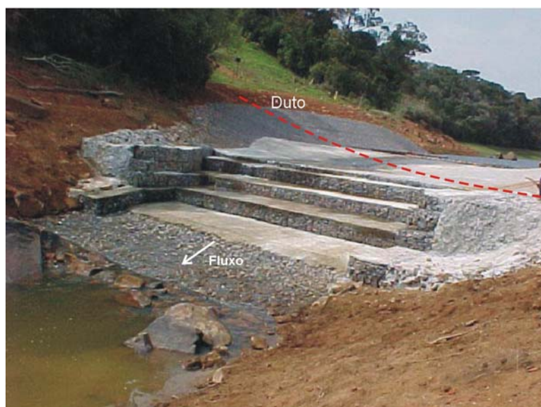
FIGURA 72 – Vista das obras de proteção concluídas (detalhe da dissipação a jusante). Fonte: OLIVEIRA e VASCONCELLOS, 2003.
