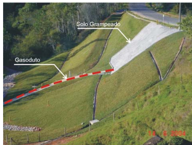
FIGURA 63 – Vista geral das obras de estabilização – muro de terra nas laterais e solo grampeado. Fonte: OLIVEIRA e VASCONCELLOS, 2005b.
