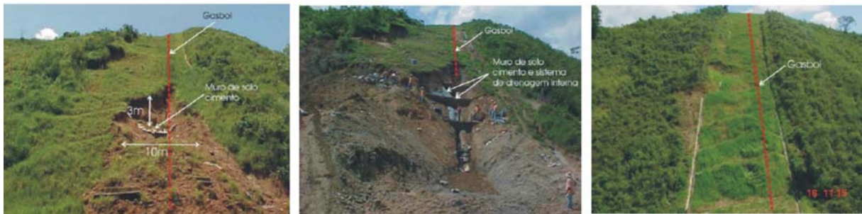
FIGURA 61 – Seqüência executiva de uma obra de recuperação de erosão. Fonte: OLIVEIRA e VASCONCELLOS, 2004, p. 202.
