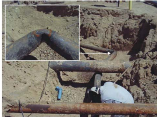
FIGURA 45 - Ruptura da Linha 1203 devido a subsidência da fundação. Fonte: YOUNDEN et al., 2002, p. 3.
