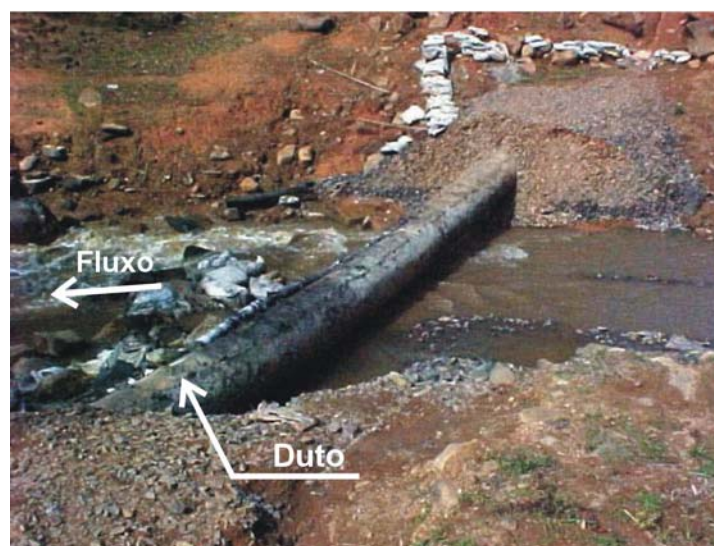
FIGURA 70 – Perda de suportaç o de duto numa travessia de reservat rio. Fonte: OLIVEIRA e VASCONCELLOS, 2003.
