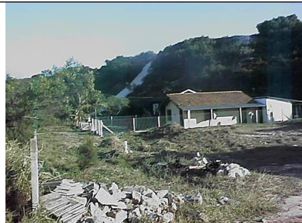
Fig. 43 -Av. Rendeiras: Edificação sobre duna APP.
