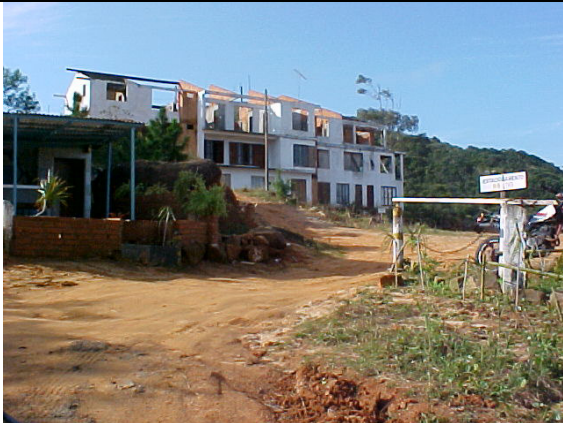
Fig. 31 - Caminho da Barra: Ocupação indevida em APP (embargada)
