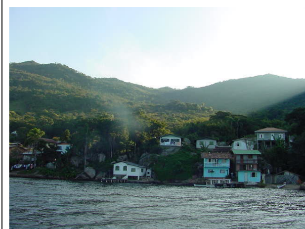
Fig. 70 - Costa da Lagoa: Ocupação indevida em APP.
