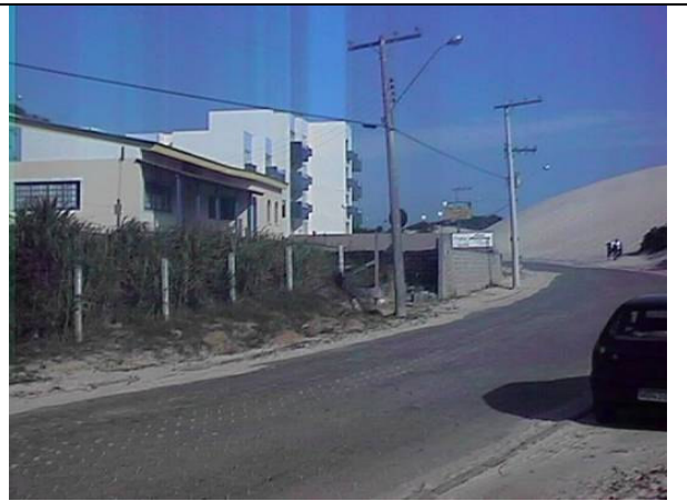
Fig. 44 - Caminho da Joaquina: Ocupação indevida em APP (duna).
