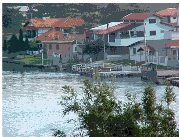
Fig. 69 - Costa da Lagoa: Ocupação indevida em APP.
