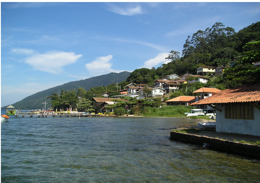
Fig. 67 - Costa da Lagoa: Ocupação indevida em APP.
