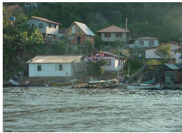
Fig. 65 - Costa da Lagoa: Ocupação indevida em APP.
