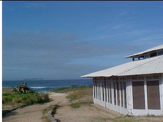
Fig. 33 - Caminho da Barra: Quiosque sobre rampa de dissipação (restinga).
