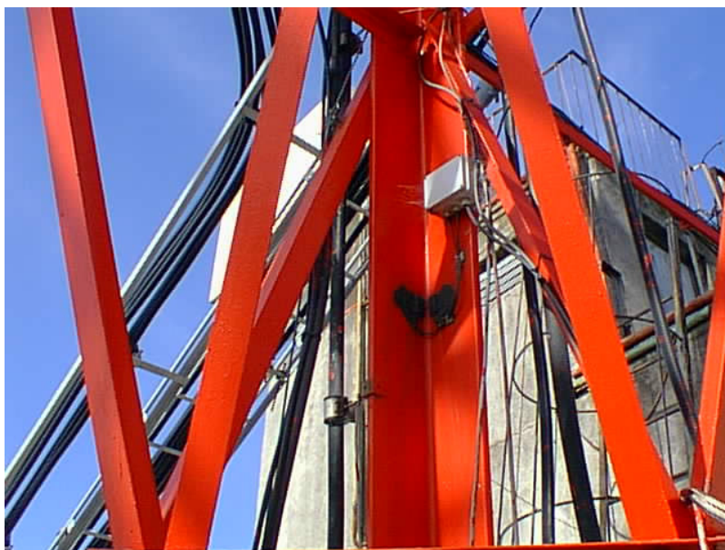
Figura 5-13 Detalhe dos extensômetros colados na base
