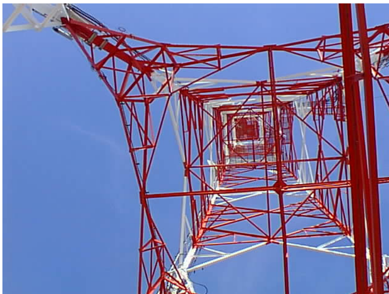
Figura 5-3 Visão da parte inferior da torre
