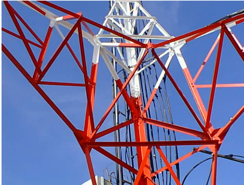
Figura 5-4 Detalhe do encontro das barras.
